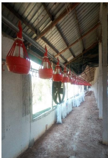
Pavilhão A-Suspensão de equipamentos fixos
