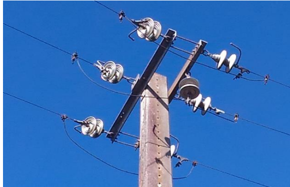
Figura 5: Isoladores inseridos em cadeia de amarração no apoio (Fonte: comum.rcaap.pt)
