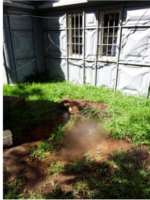
Figura 7: Parte extena da casa de ferro
