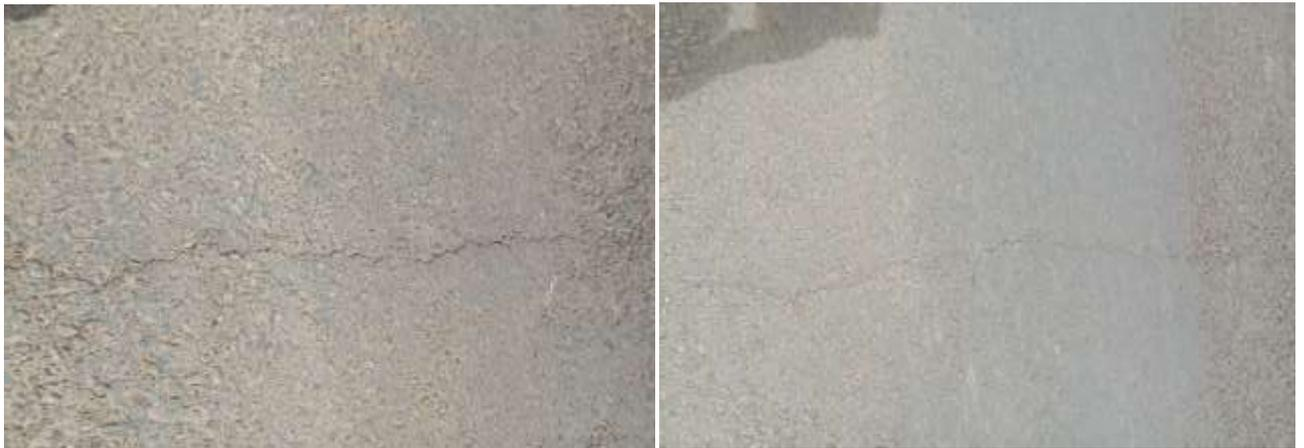
Figura 20: Fendas transversais- Fonte: Adaptado pelo autor
