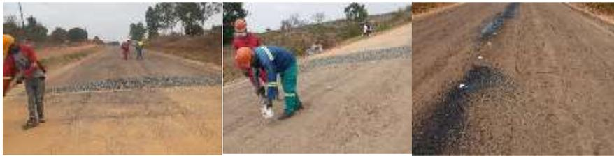
Figura 40: Limpeza e marcação do eixo-Fonte: Adaptado pelo autor
