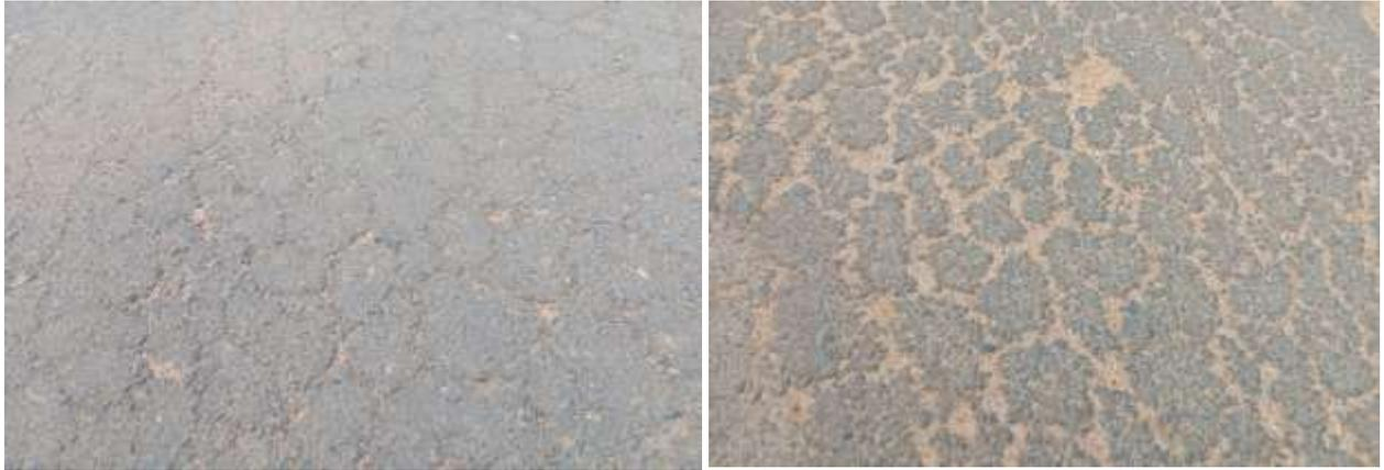
Figura 24: Fendas do tipo pele de crocodilo- Fonte: Adaptado pelo autor
