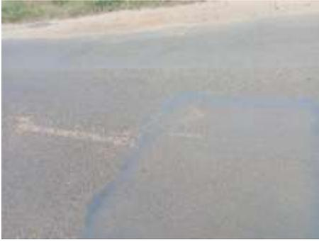
Figura 27: Remendo- Fonte: Adaptado pelo autor
