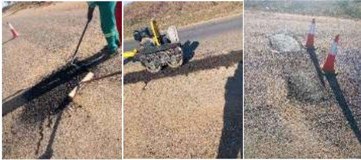
Figura 36: Colocação da massa betuminosa, compactação e o aspecto final–Fonte: Adaptado pelo autor
