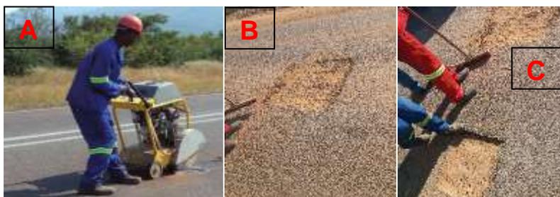
Figura 33: Operações de corte (A) e limpeza da área cortada—Fonte: A—ANE (2015), B e C—Adaptado pelo autor
