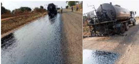
Figura 41: Aplicação do ligante na superfície imprimada- Fonte: Adaptado pelo autor
