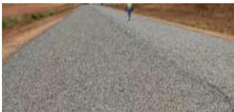
Figura 44: Aspecto final após a conclusão da primeira camada do TSD-Fonte: Adaptado pelo autor
