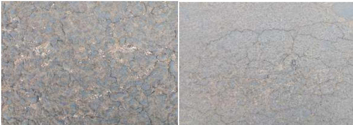
Figura 22: Fendas em bloco- Fonte: Adaptado pelo autor
