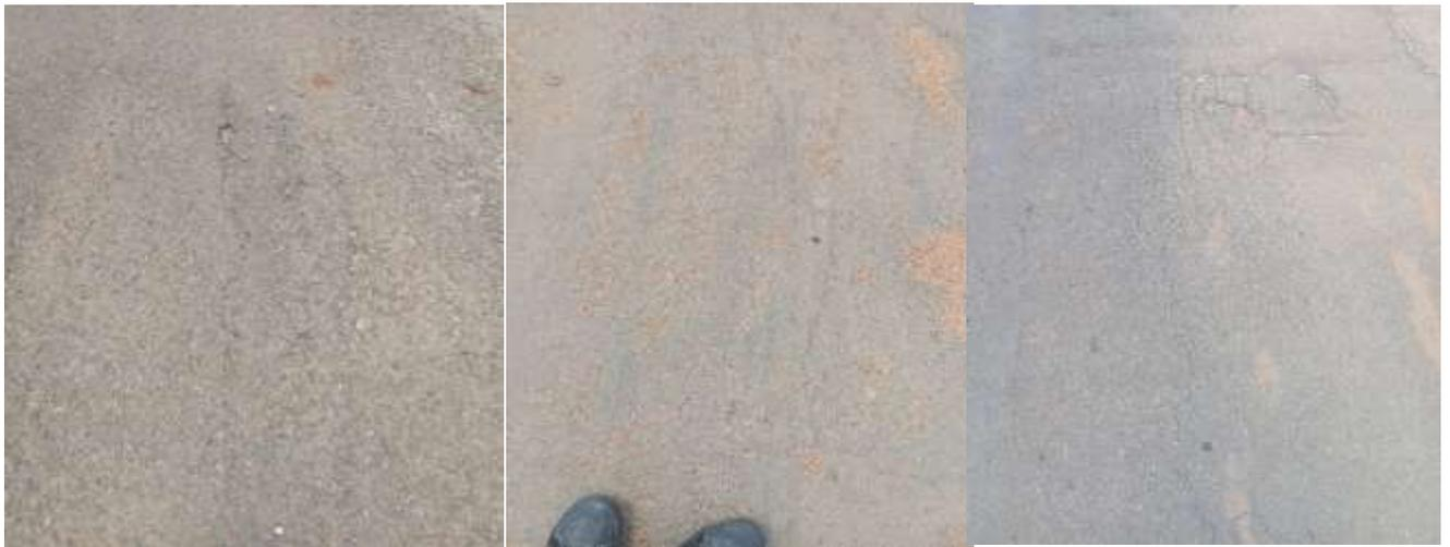
Figura 19: Fendas longitudinais- Fonte: Adaptado pelo autor
