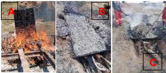
Figura 35: A-Aquecimento do betume; B-Aquecimento dos agregados e C-mistura da massa quente-Fonte: Adaptado pelo autor
