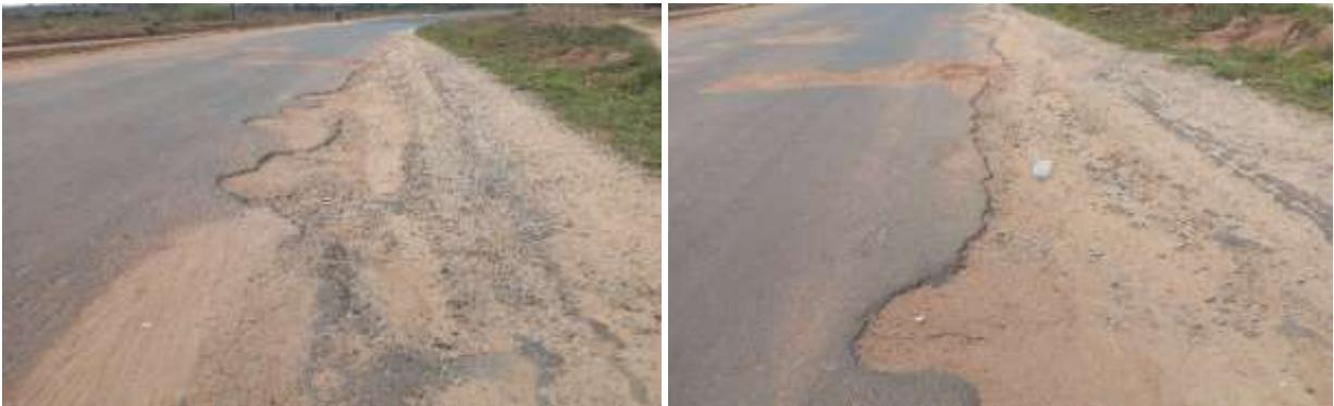
Figura 28: Colapso dos bordos- Fonte: Adaptado pelo autor
