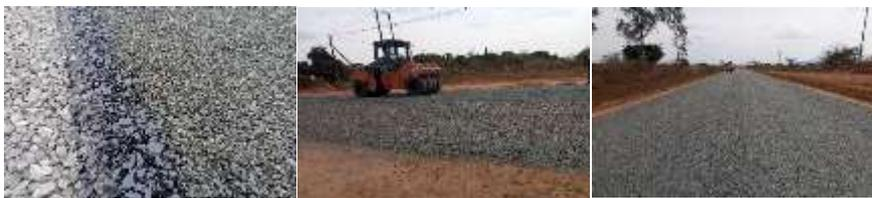
Figura 46: Compactação e o aspecto final do pavimento-Fonte: Adaptado pelo autor
