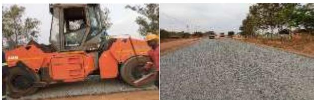
Figura 43: Compactação dos agregados-Fonte: adaptado pelo autor
