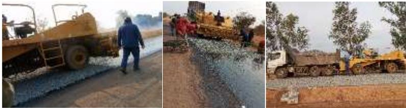
Figura 42: Espalhamento do agregado-Fonte: Adaptado pelo autor
