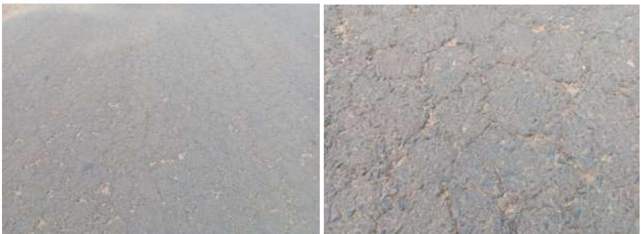
Figura 23: Fendas do tipo pele crocodilo- Fonte: Adaptado pelo autor
