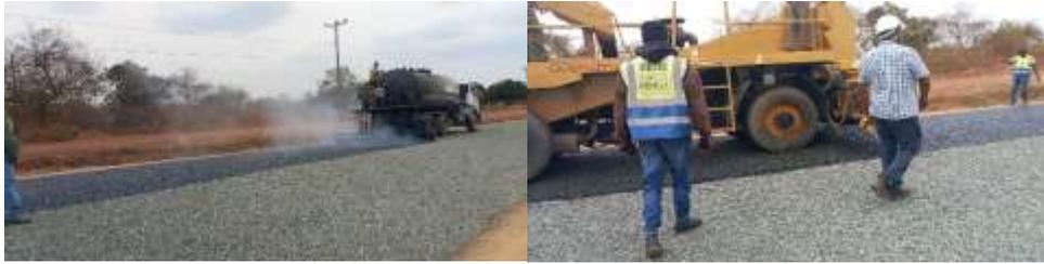
Figura 45: Aplicação do ligante e o espalhamento da segunda camada do agregado-Fonte: adaptado pelo autor
