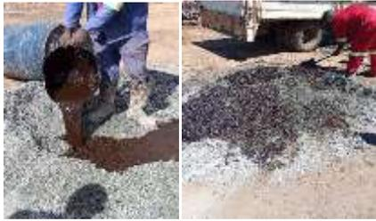
Figura 34: Preparação da mistura da massa fria- Fonte: Adaptado pelo autor
