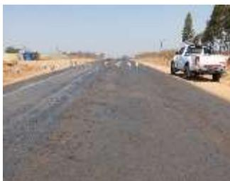
Figura 39: Aspecto final da base após a impregnação com MC30–Fonte: Adaptado pelo autor
