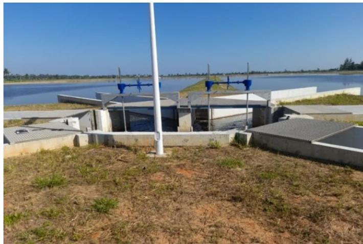
Figura 13: ponto de encontro onde todas as águas residuais vindas das LAN
