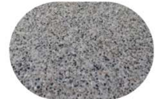
g - concreto lavado/cimento
