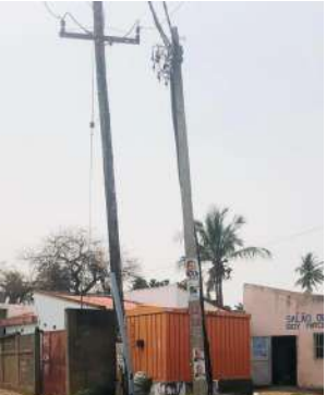
Figura50: Equipamentos da rede electrica Fonte: Autor
