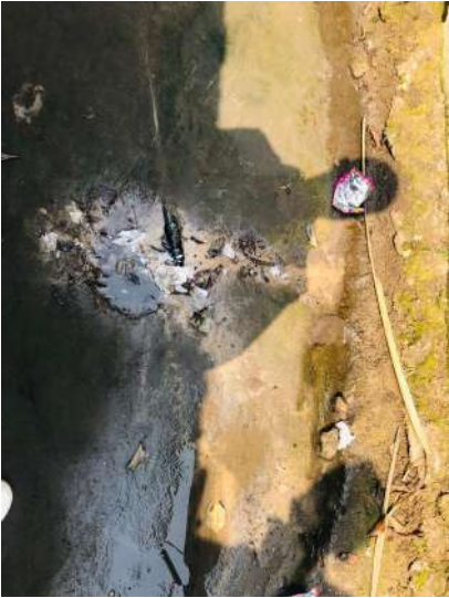
Figura47: fuga de agua Fonte: Autor
