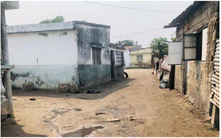
Figura33: Arquitetura Local em mau estado Fonte:Autor
