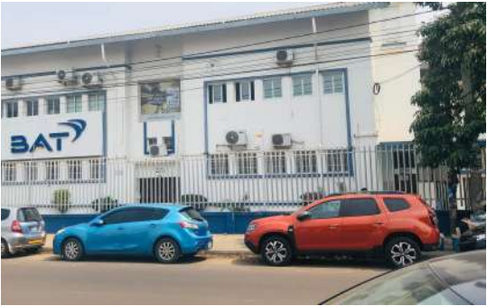
Figura44: Serviços ao longo da Av. Angola Fonte: Autor
