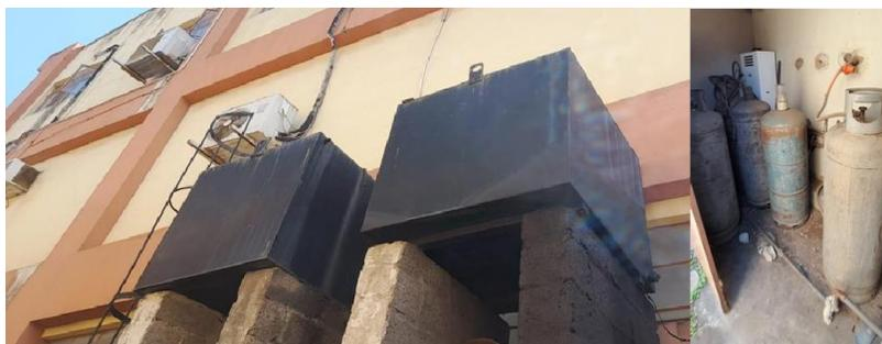
*Figura 23: Tanques de armazenamento de combustíveis e botijas de gás sem sinalização*
