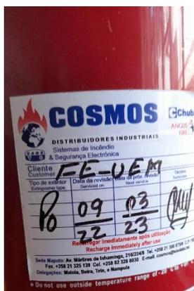
Figura 26: Extintores (todos) com data de Inspeção vencida
