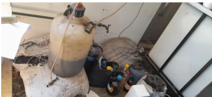
*Figura 13: Produtos inflamáveis deixados no Chão com cabos eléctricos*
