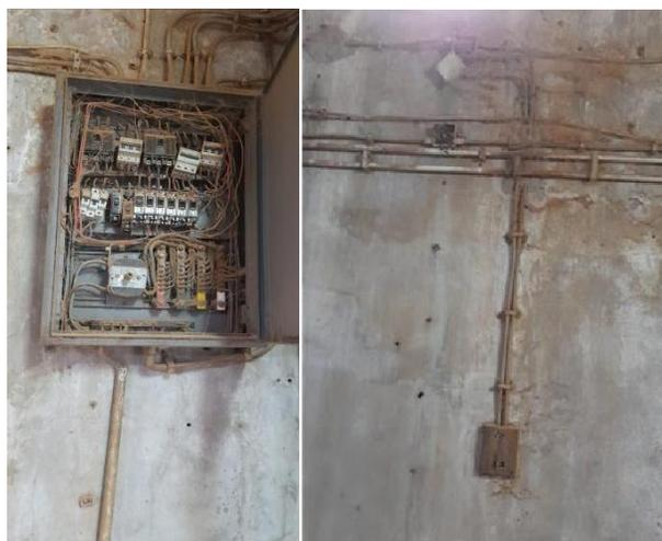
*Figura 22: Quadro eléctrico e fiação em péssimas condições*
