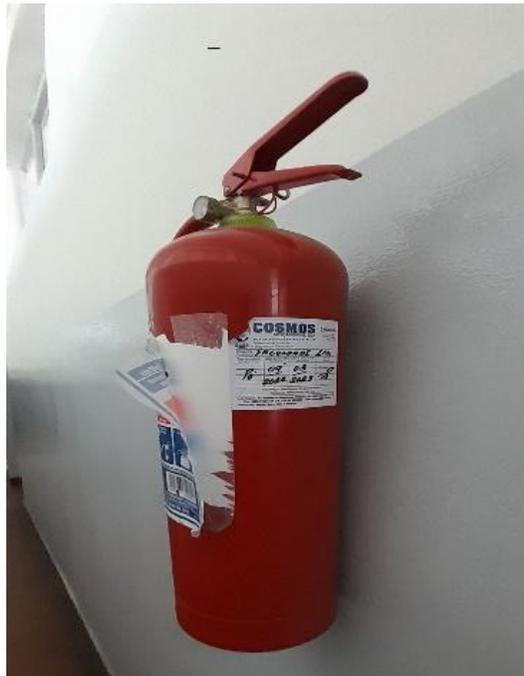
*Figura 25: Extintor das cadeiras Gerais com a Etiqueta de Inspeção Rasgada*
