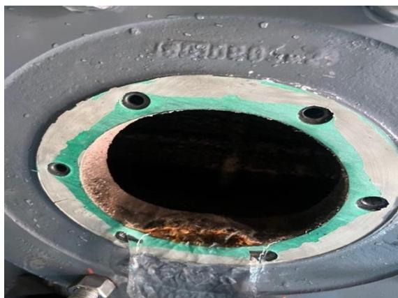
Foto 7: Corrosão no compressor de ar.
