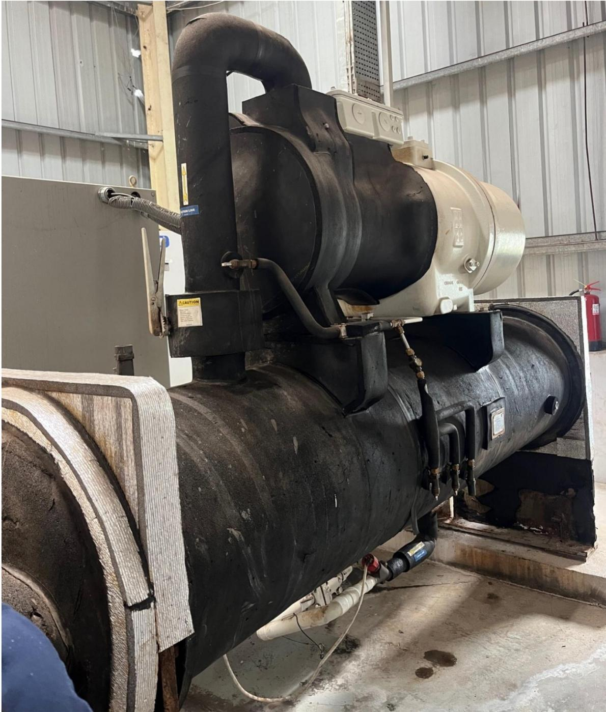
Foto A5-6: Compressor e evaporador.
