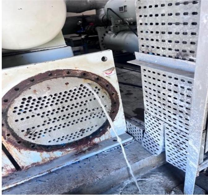
*Foto 1: Trocador de casco e tubo*
