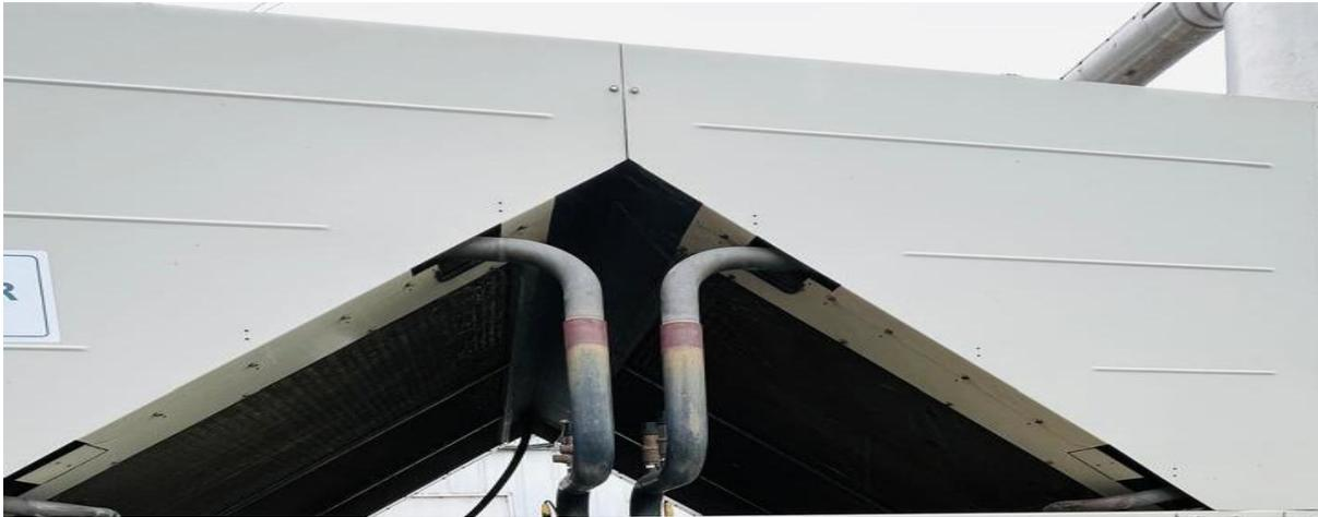
*Figura 7: Condensador do tipo Hélice*
