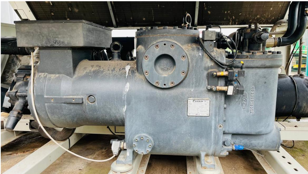
Figura 5: Compressor semi-hermético de parafuso
