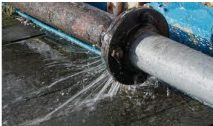
Figura 2- Fuga em elemento de ligação. Fonte: *internet*.
