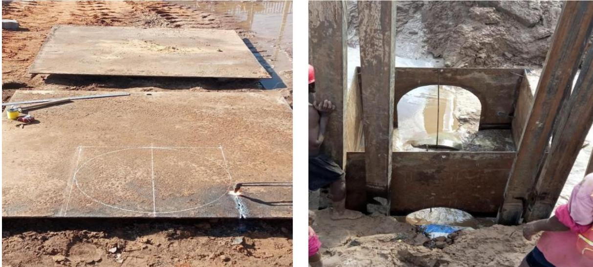
*Figura 22: Construção e fixação da cofragem metálica para a caixa de inspeção.*
