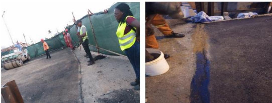
*Figura 39: Processo de selagem das juntas.*
