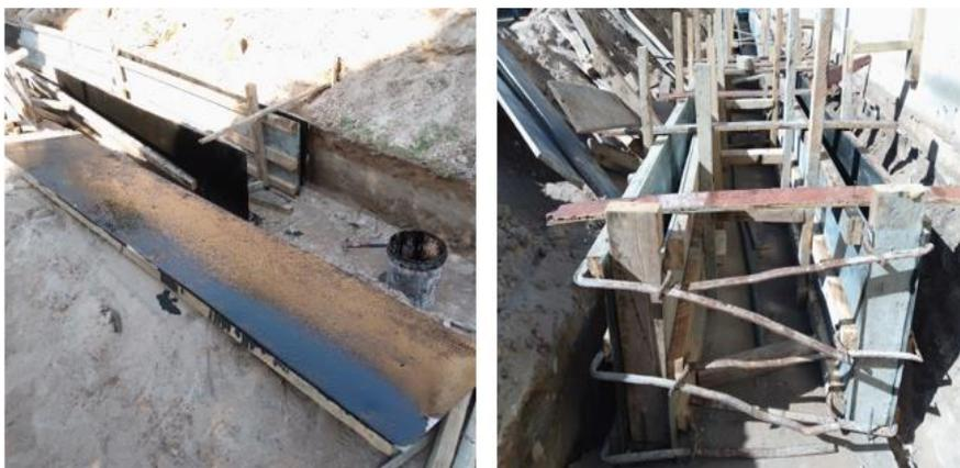
*Figura 64: Sistema de cofragem.*
