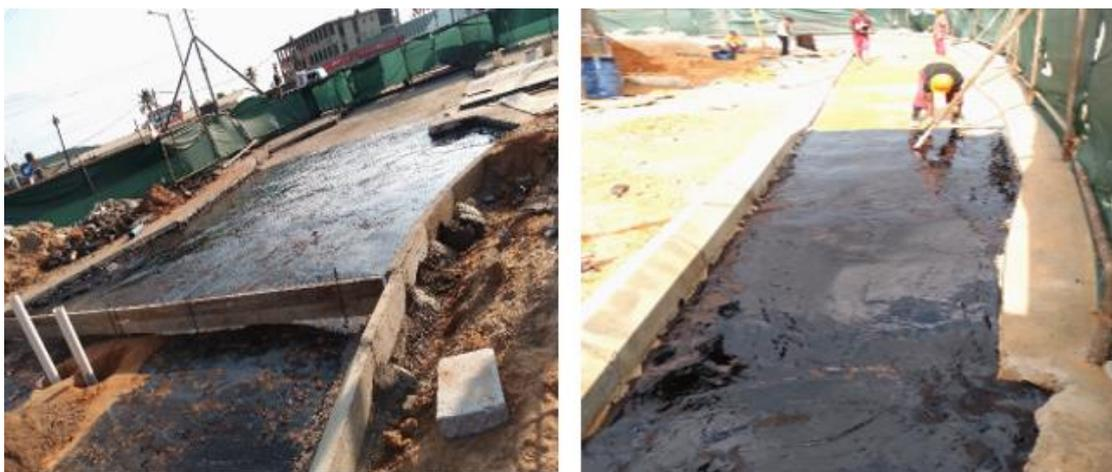
*Figura 31: MC30 aplicado sobre uma camada de sub-base (a esquerda) e sobre uma camada de base (a direita).*
