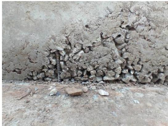
*Figura 77: Defeitos devido ao fraco adensamento do betão..*
