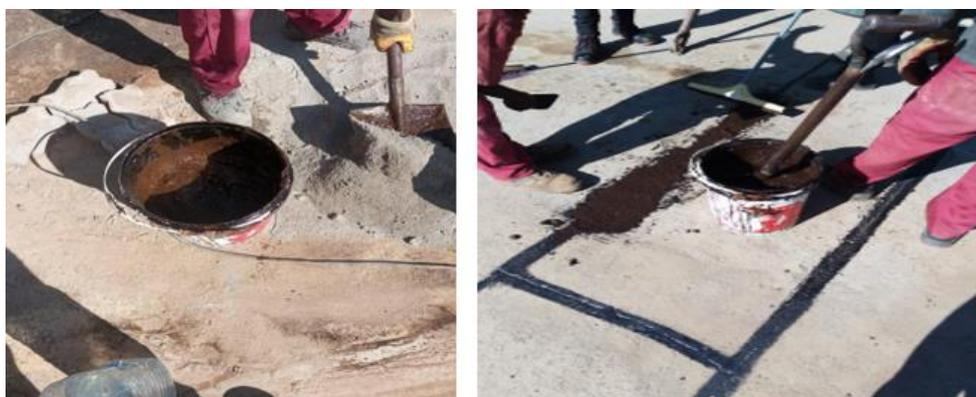
*Figura 40: Preparação e aplicação da lama asfáltica para selar as fissuras.*
