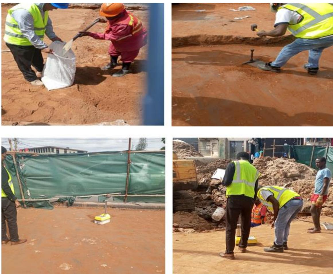
Figura 29: Recolha do material da sub-base para ensaio e realização de ensaio no terreno pelo LEM.
