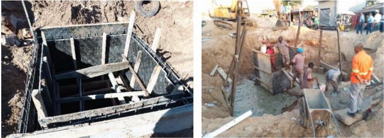
*Figura 24: Colocação da armadura e das chapas de cofragem de madeira (a esquerda) e betonagem da caixa de inspeção (a direita).*
