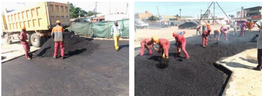
*Figura 33: Chegada do material da base, espalhamento e nivelamento.*
