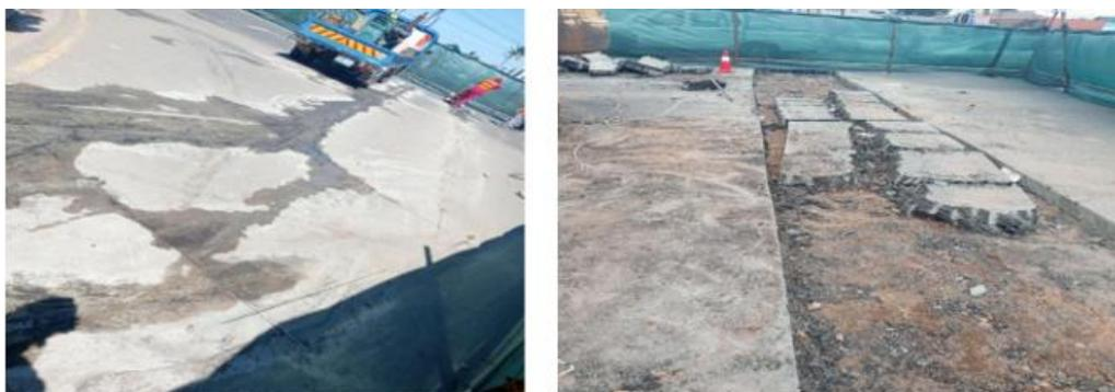
*Figura 11: Demarcação e início da remoção da camada de revestimento do pavimento.*
