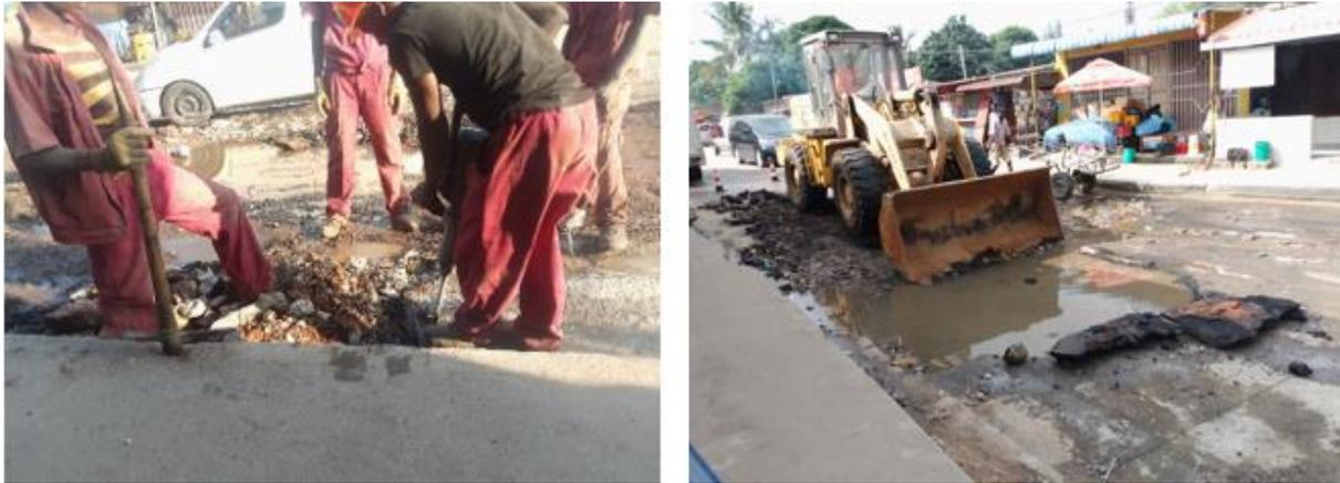
*Figura 49: Remoção do pavimento flexível.*
