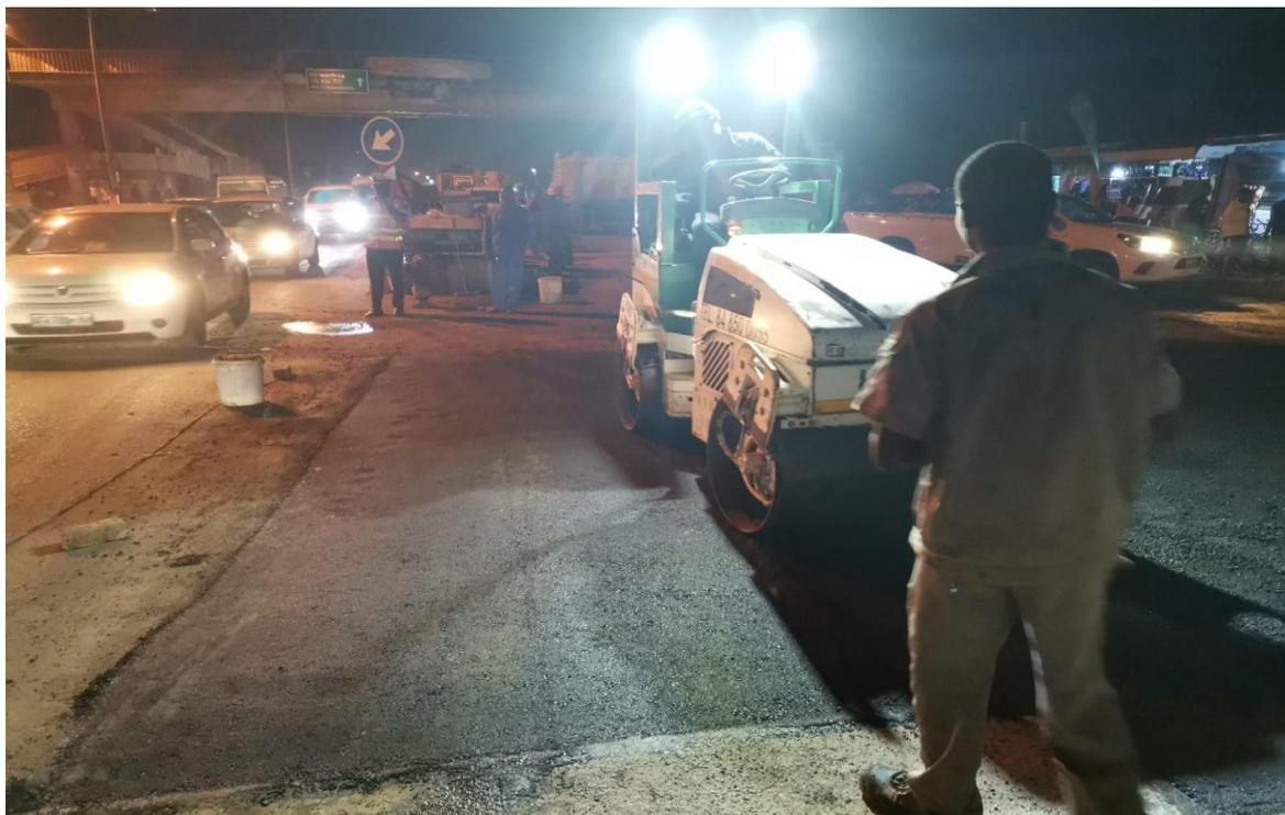
*Figura 37: Compactação do asfalto.*
