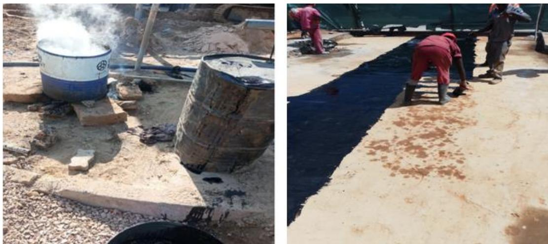
*Figura 30: Rega de impregnação com MC30: aquecimento e colocação.*
