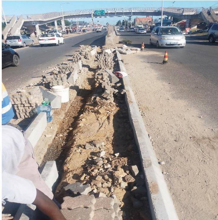
*Figura 46: Reposição dos lancil e pavês do separador de faixas.*
