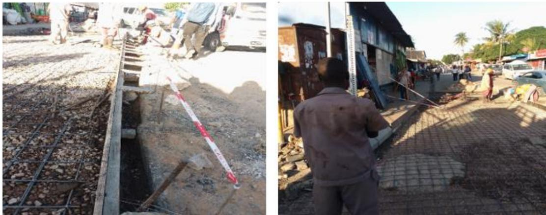
Figura 51: Colocação da cofragem e controle da inclinação de projecto.
