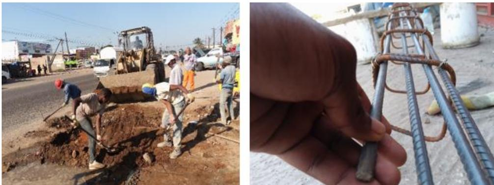
*Figura 69: Escavação e armadura para as vigas da laje.*
