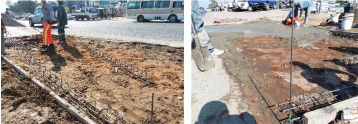
*Figura 70: Execução da laje.*
