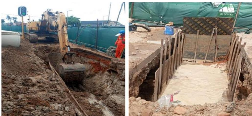
*Figura 13: Escavação e contenção de solos na zona de assentamento das manilhas*
