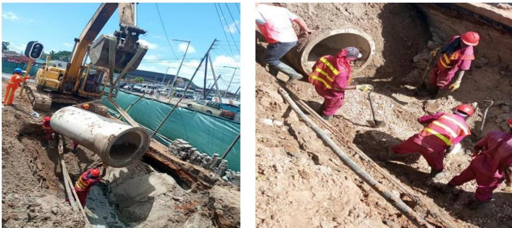
*Figura 16: Assentamento da manilhas (a esquerda), colocação do betão para a laje de fundo da manilha (a direita).*
