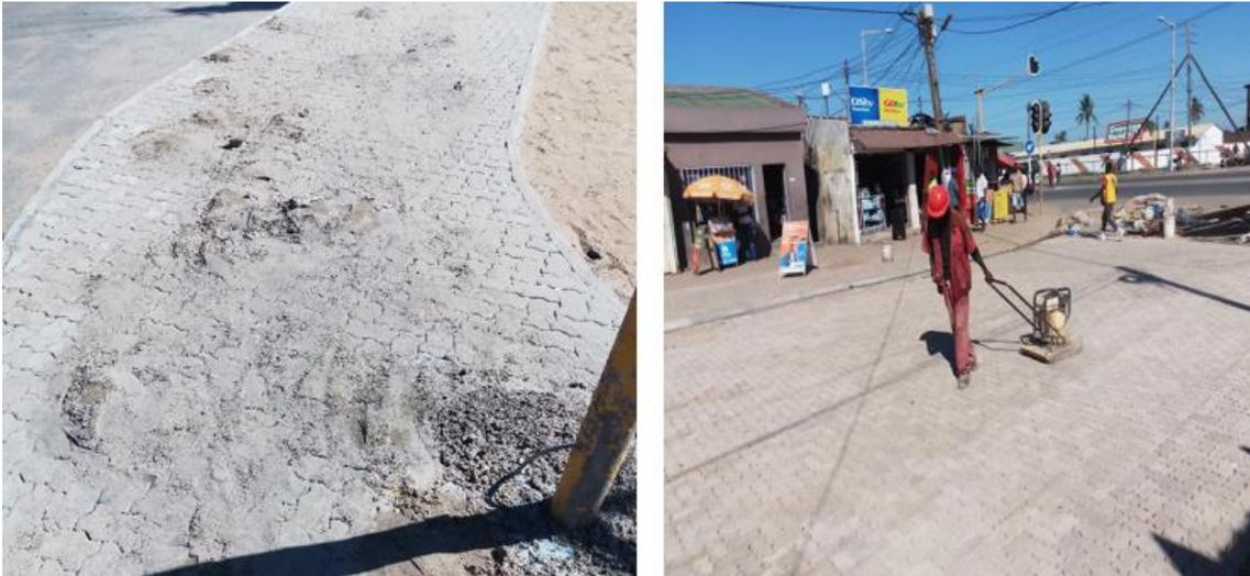
*Figura 44: Lançamento de areia fina sobre os pavês (a esquerda) e compactação dos pavês (a direita).*
