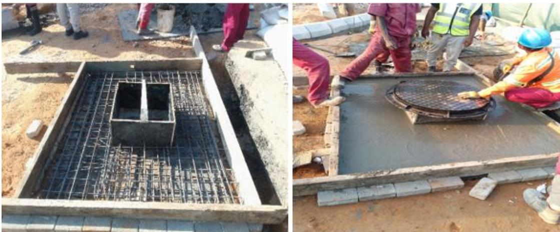
Figura 21: Colocação da armadura e betonagem da tampa da caixa de ligação.
