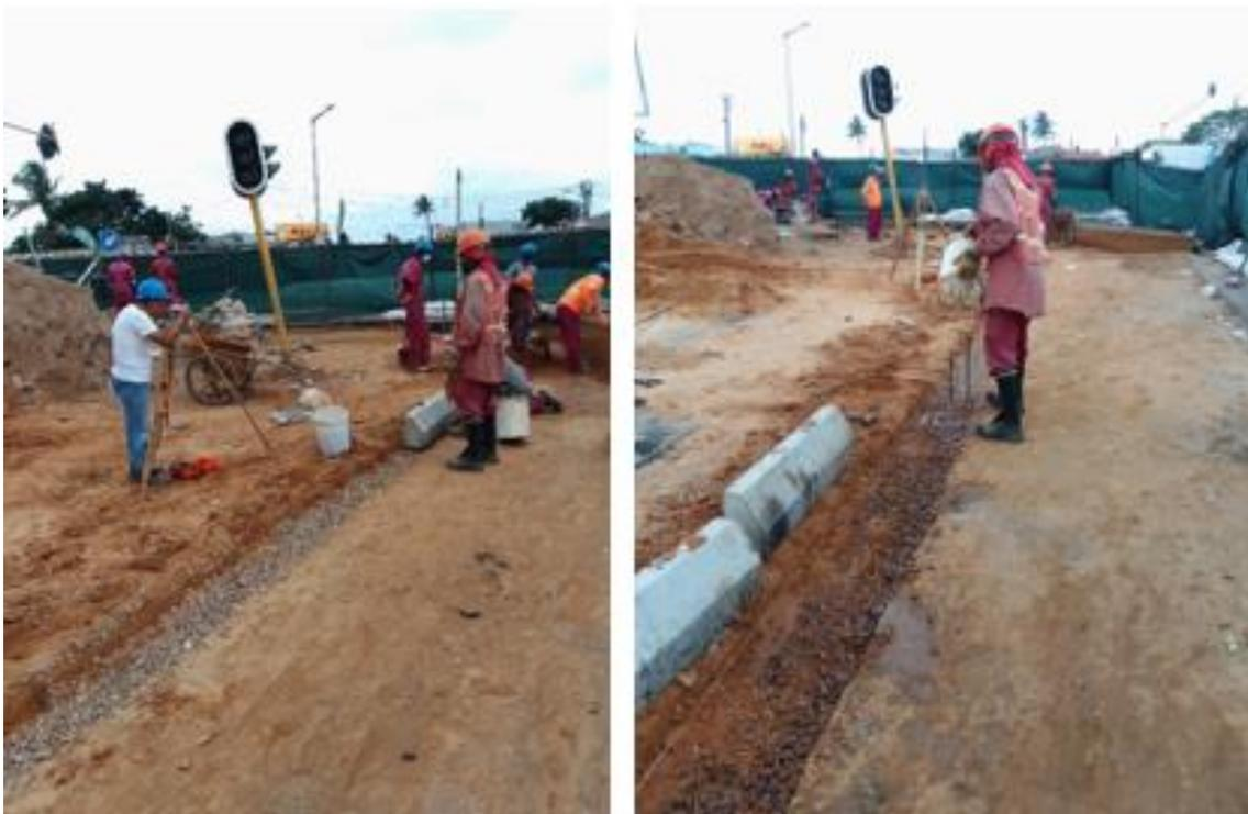
*Figura 41: Colocação da pedra e rega para o assentamento dos lancis.*
