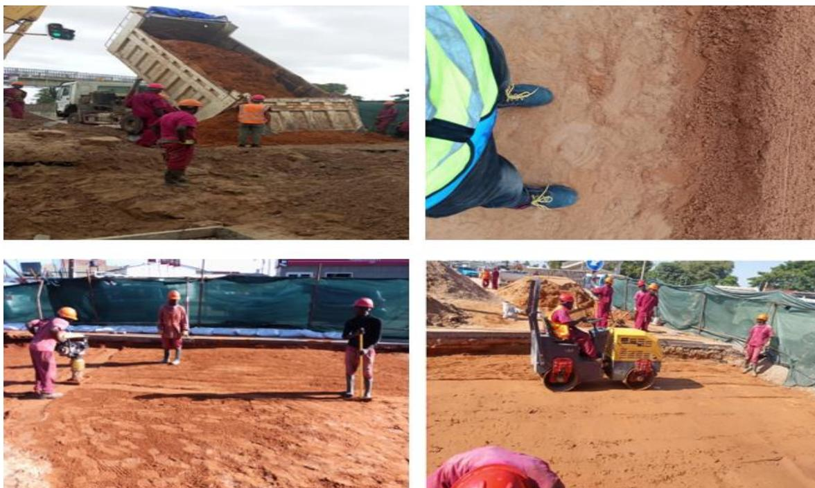
Figura 27: Alocação, espalhamento, nivelamento e compactação do solo selecionado.
