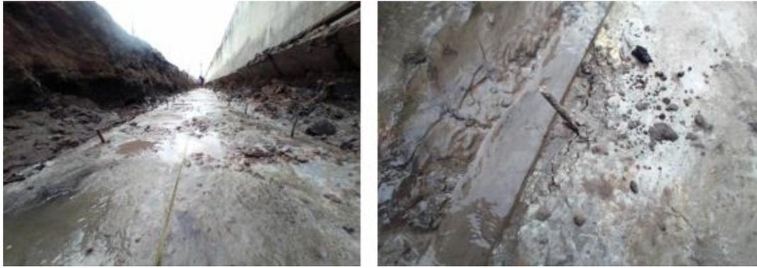
*Figura 74: Segregação do betão da laje de fundo devido ao excesso de água e ocorrência de fissuras.*
