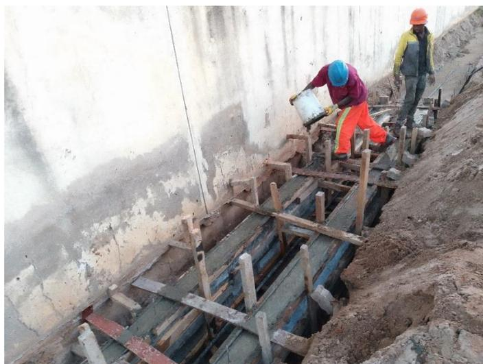
*Figura 65: Betonagem das paredes.*
