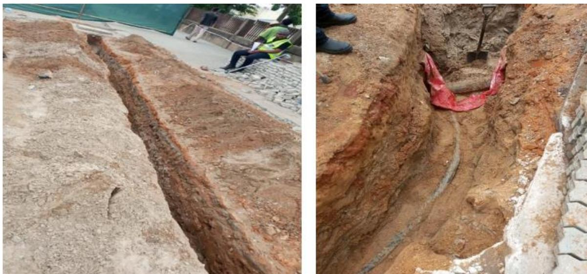
*Figura 12: Processo de escavação manual para a sondagem de passagem de serviços (a esquerda). Conduto de gás e cabo elétrico (a direita).*
