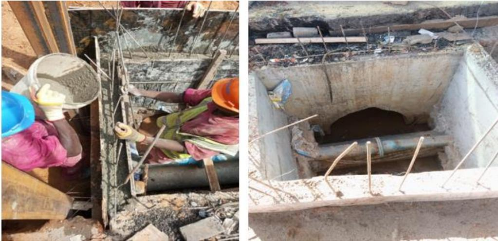
Figura 20: Betonagem das paredes da caixa de ligação.
