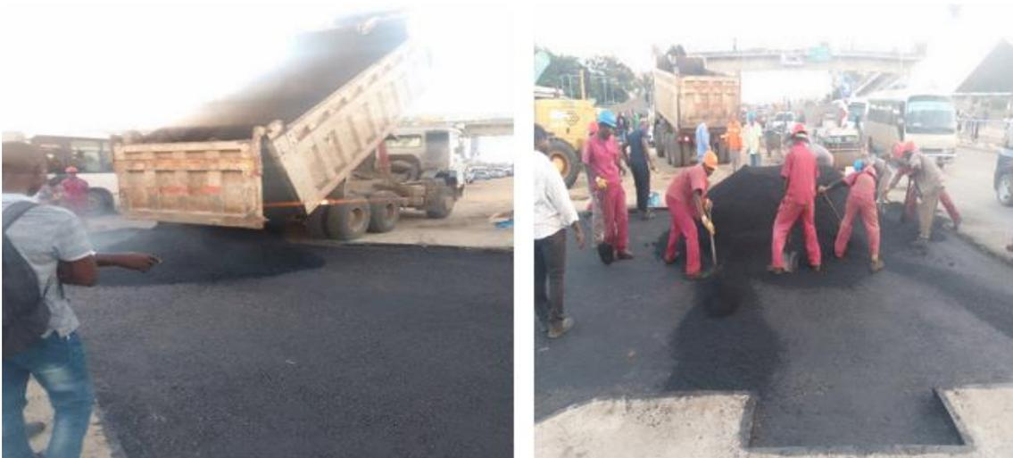
*Figura 36: Chegada, espalhamento do asfalto na obra.*
