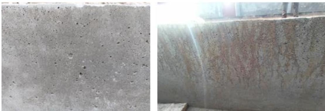
*Figura 76: Betão com uma mistura homogénea (à esquerda) e betão com uma mistura não homogénea (à direita)*
