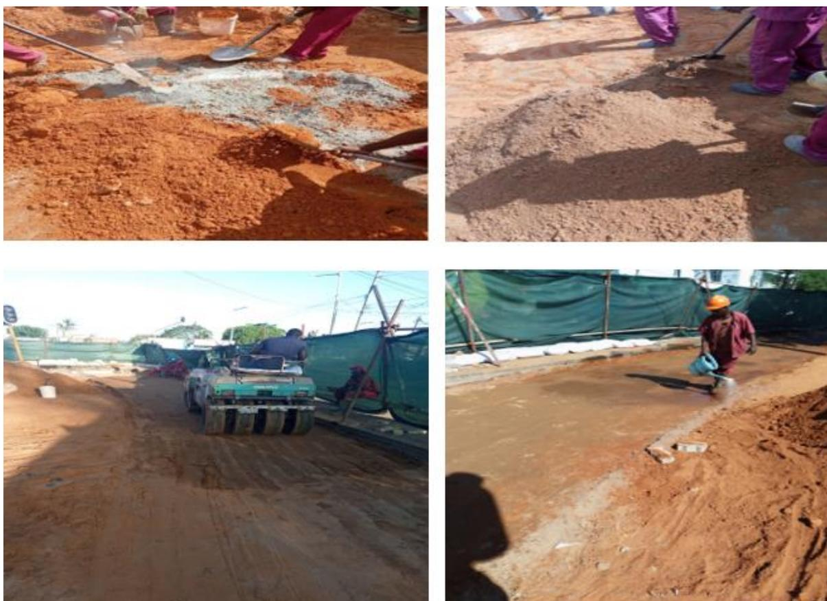
*Figura 28: Estabilização do solo cimento, nivelamento, compactação e rega.*
