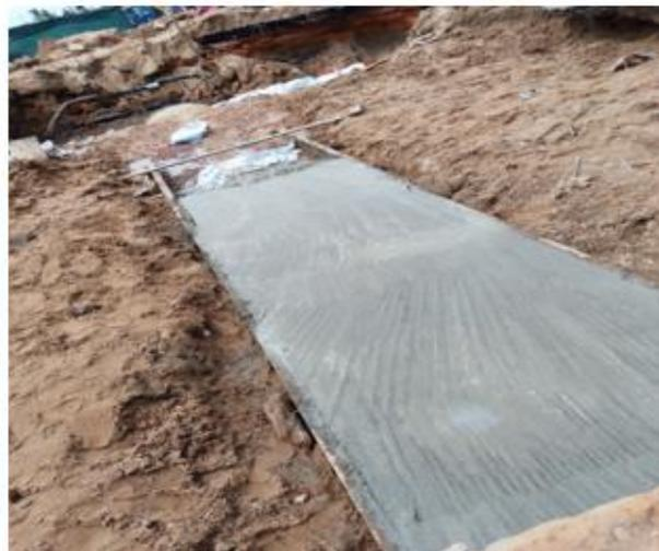
*Figura 17: Controle da inclinação da manilha e execução da laje de topo sobre a manilha.*
