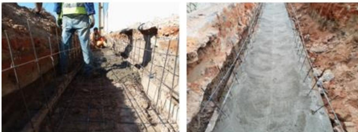
*Figura 63: Execução da laje de fundo.*
