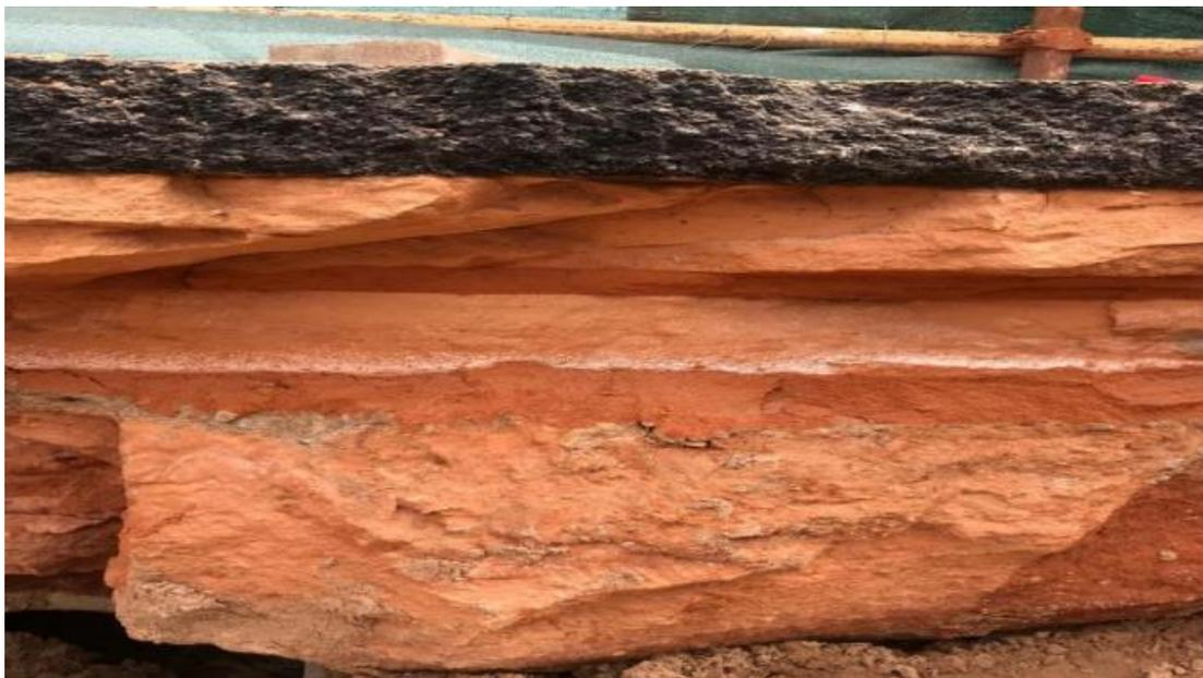
*Figura 25: Estrato das camadas da estrutura do pavimento na zona de intervenção.*
