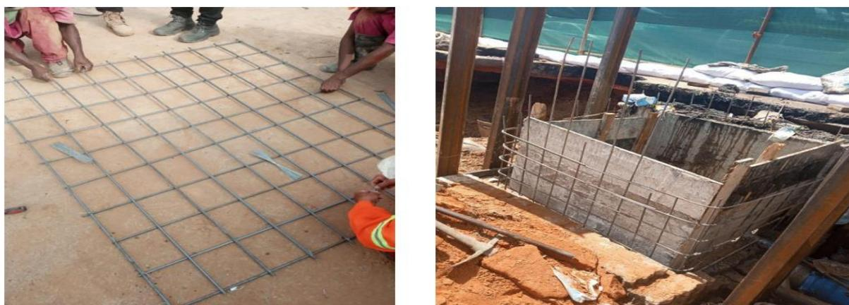
Figura 19: Armação e cofragem da caixa de betão armado.
