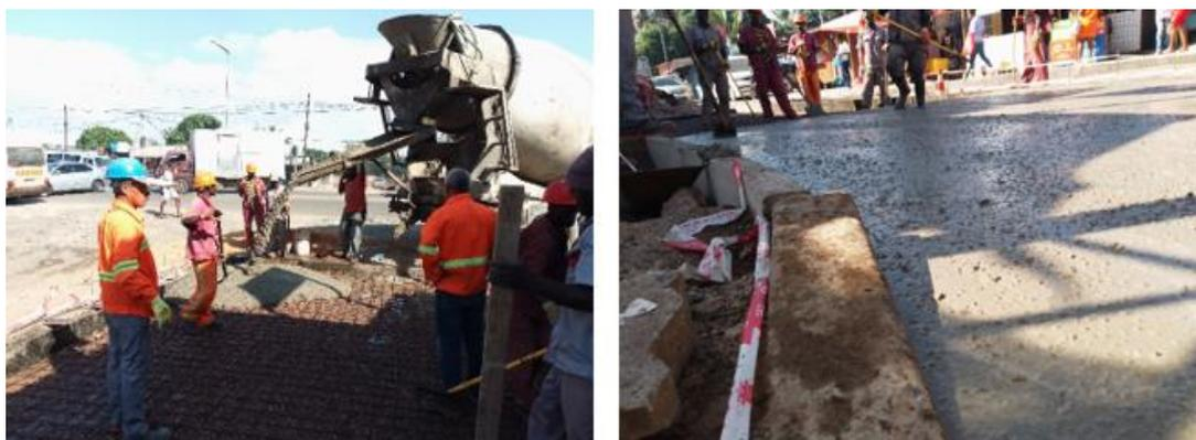
*Figura 53: Processo de betonagem, espalhamento e adensamento do betão.*
