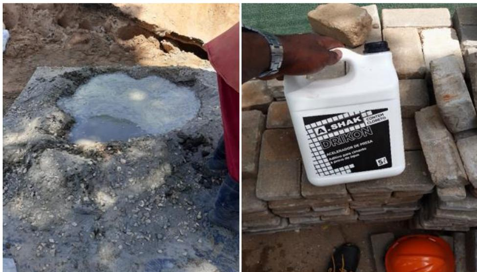
Figura 18: Produção manual do betão na obra (a esquerda) e o aditivo de endurecimento rápido, DRIKON (a direita).
