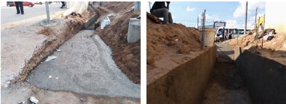
*Figura 72: Ligação da Laje e o sistema de drenagem.*
