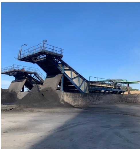
Figura 10: Estação de tratamento de águas residuais na FAX (Fonte: autor)
