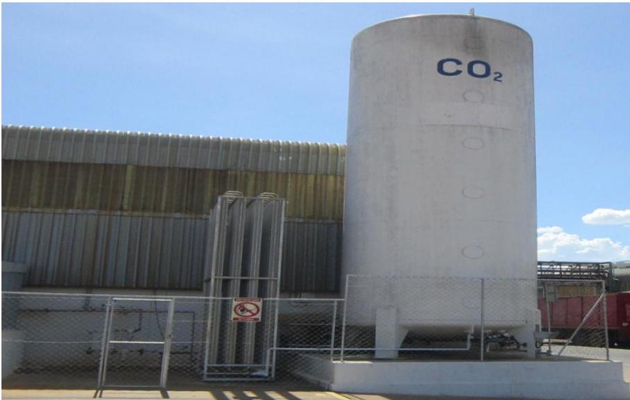
Figura 3: Tanque de CO<sub>2</sub> a direita e Vaporizadores de CO<sub>2</sub> a esquerda (serpentina)
