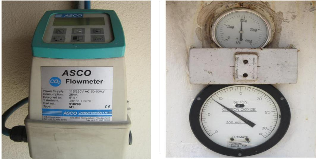
Figura 5: ASCO Flowmeter (medidor de Fluxo) e Manómetro
