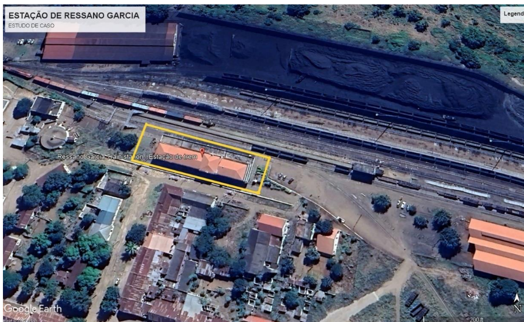
Figura 11. Estação Ferroviária de Ressano Garcia-Imagem aérea
