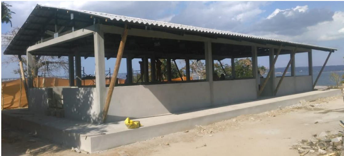
Montagem da cobertura
