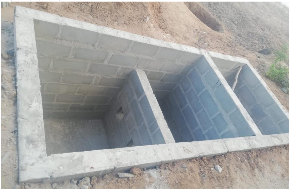
Alvenaria da fossa
