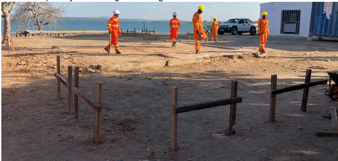
Implantação e montagem de cangalhos do mercado de peixe.
