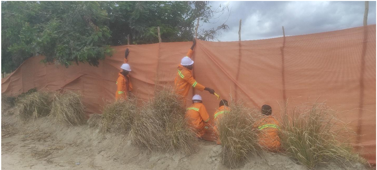
montagem da rede de vedação.
