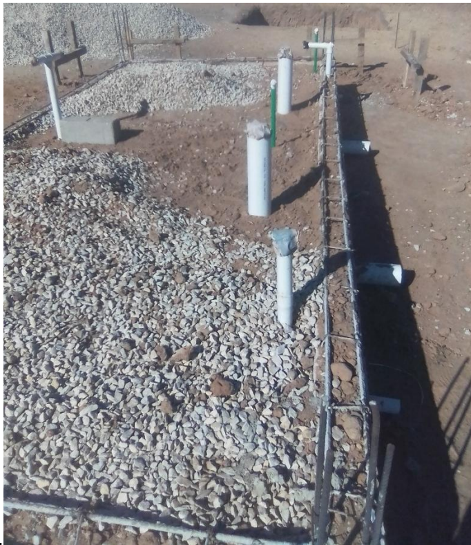
Tubos de esgotos e tubos de abastecimento
