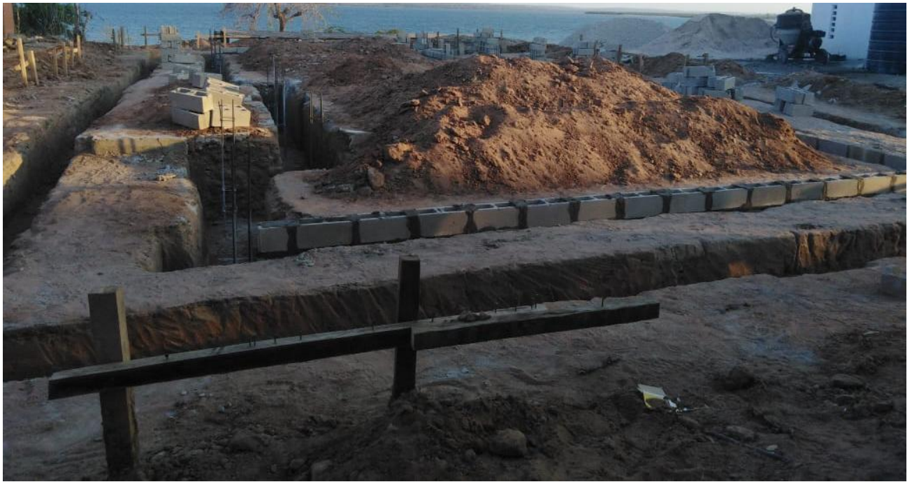
Alvenaria de fundação
