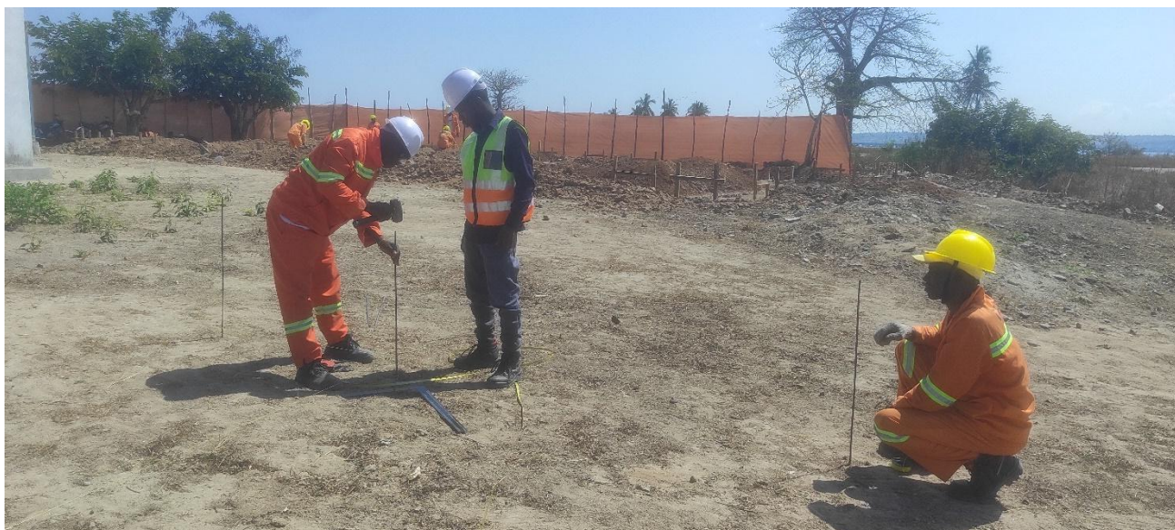
Implantação e montagem de cangalhos do sanitário do mercado de peixe.
