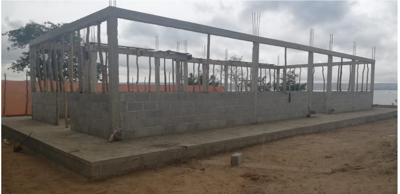
Execução de pilares no mercado
