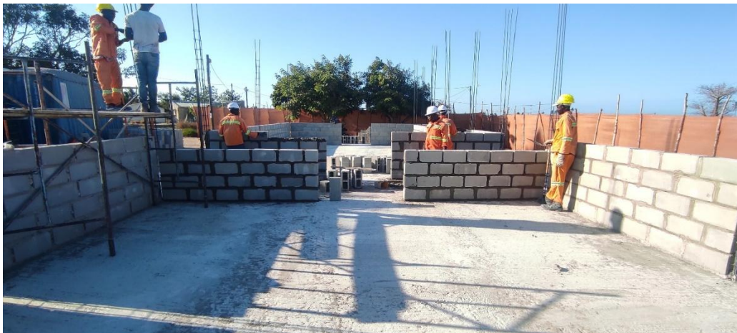
Alvenaria do mercado
