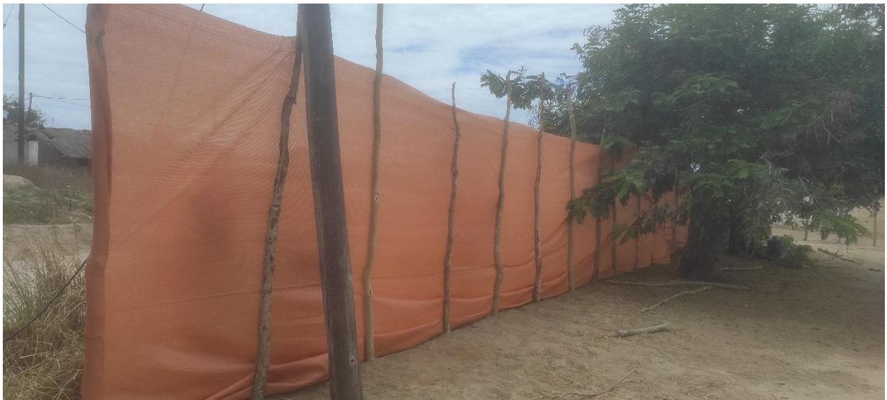
montagem da rede de vedação
