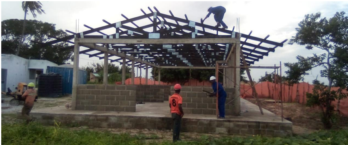
Montagem da cobertura
