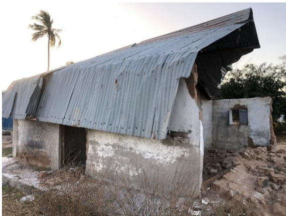
Figura 12: situação inicial do local da obra (Foto tirada pelo autor)
