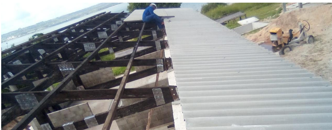
Montagem da cobertura
