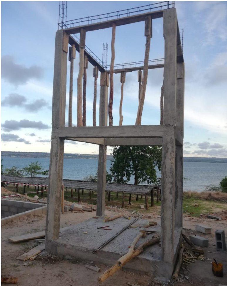
Estrutura de reservatorio superior
