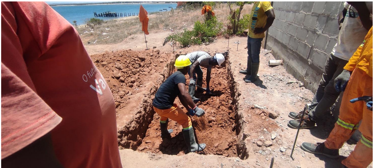
Escavação da fossa séptica
