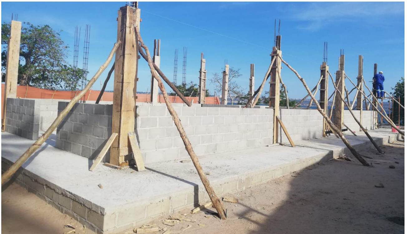
Execução de pilares no mercado
