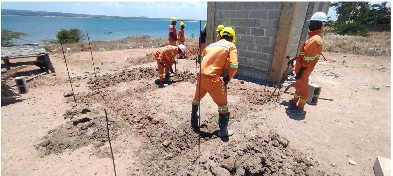
Escavação da fundação do tanque superior.
