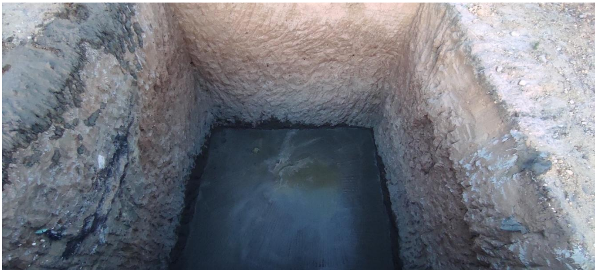
Betonagem do fundo do tanque
