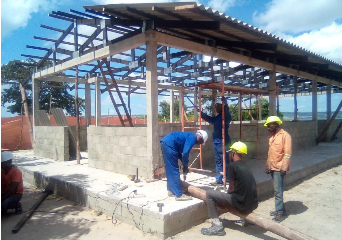
Montagem da cobertura
