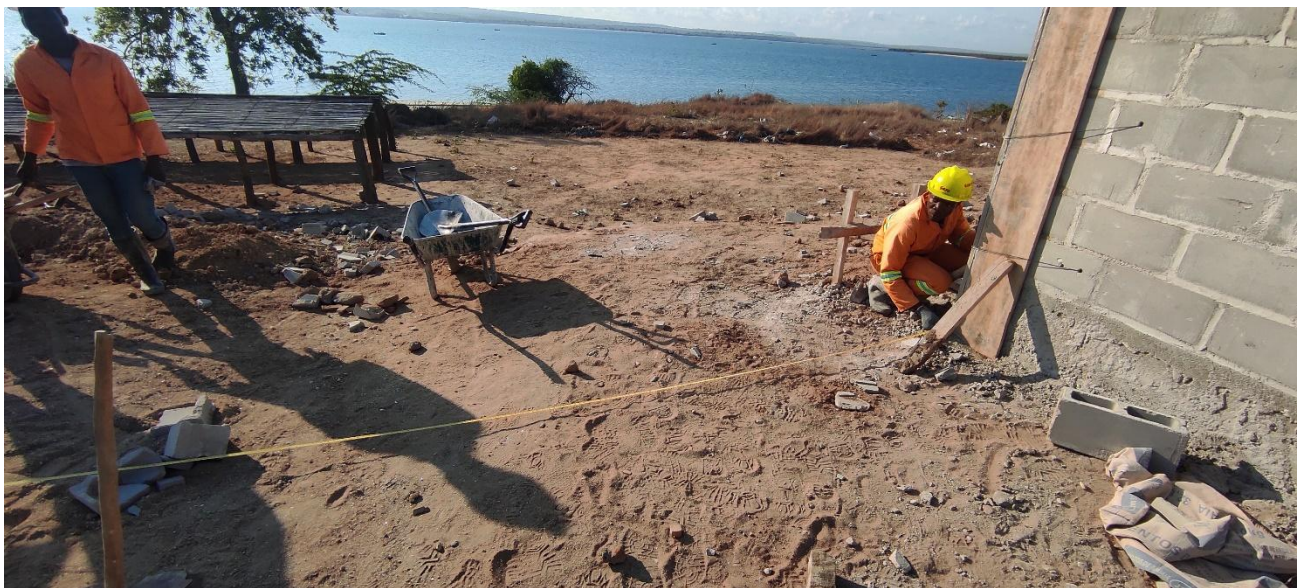
Implantação da torre de abastecimento de água.
