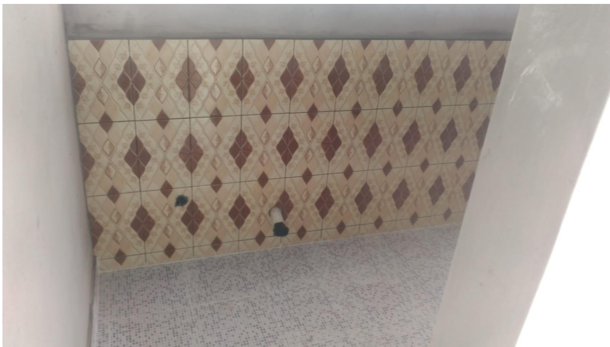
Acabamento das paredes do sanitario
