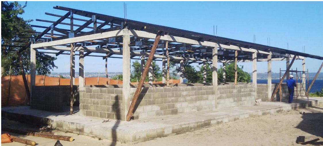
Montagem da cobertura
