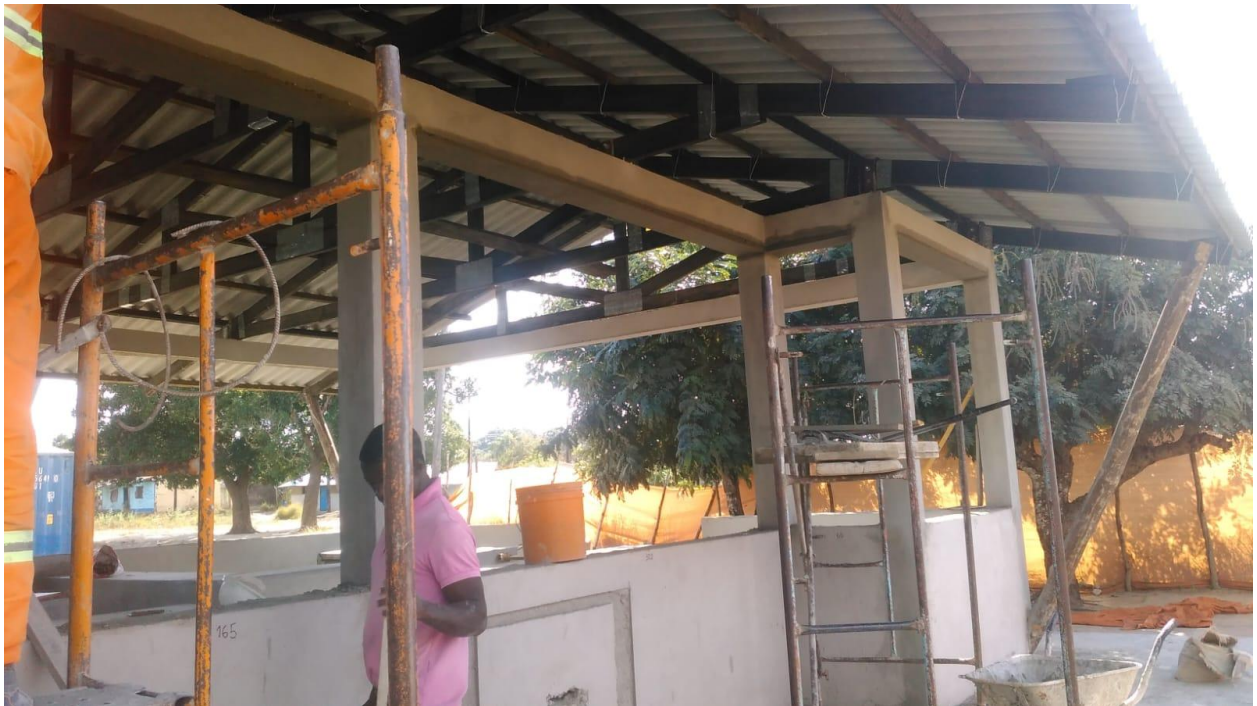
Acabamento das paredes do mercado
