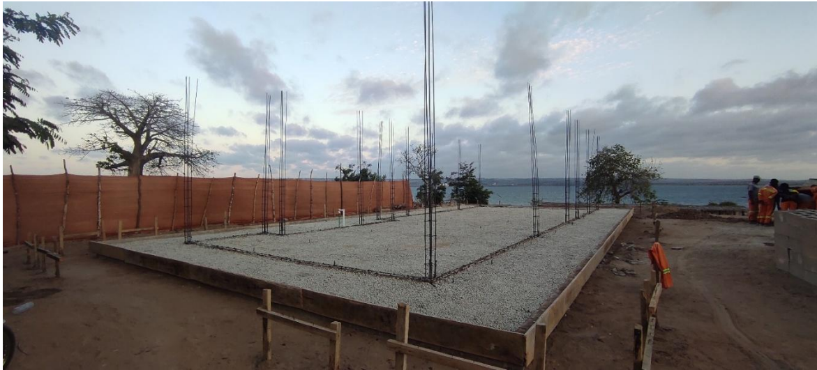
armaduras dos pilares já empalmados
