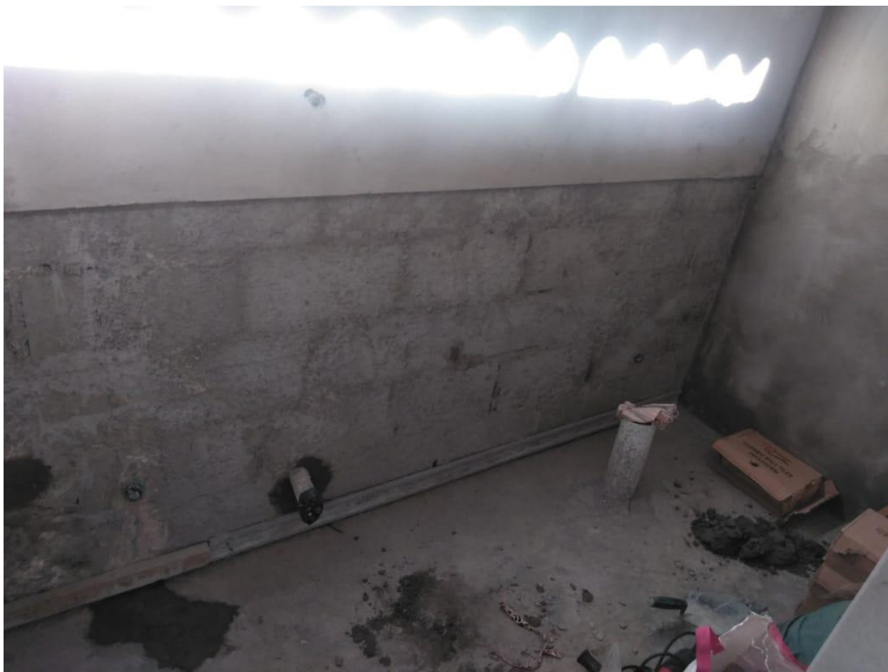
Acabamento das paredes do sanitario
