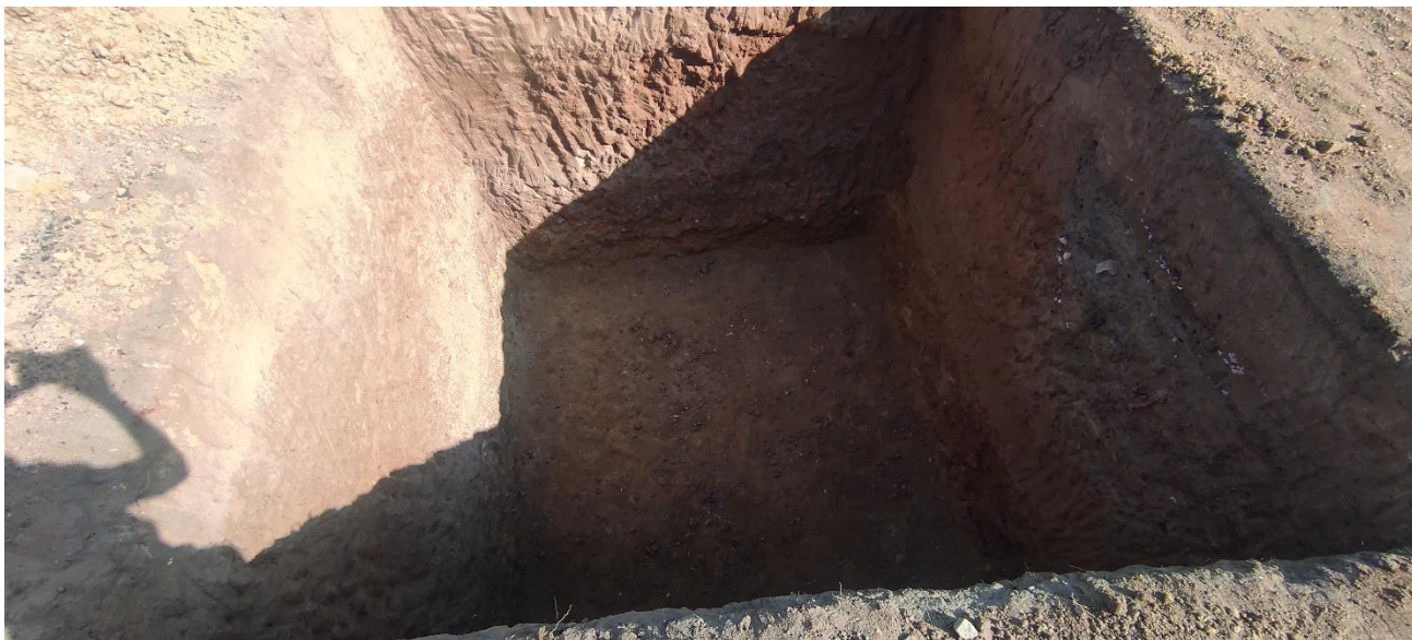
Escavação do tanque inferior
