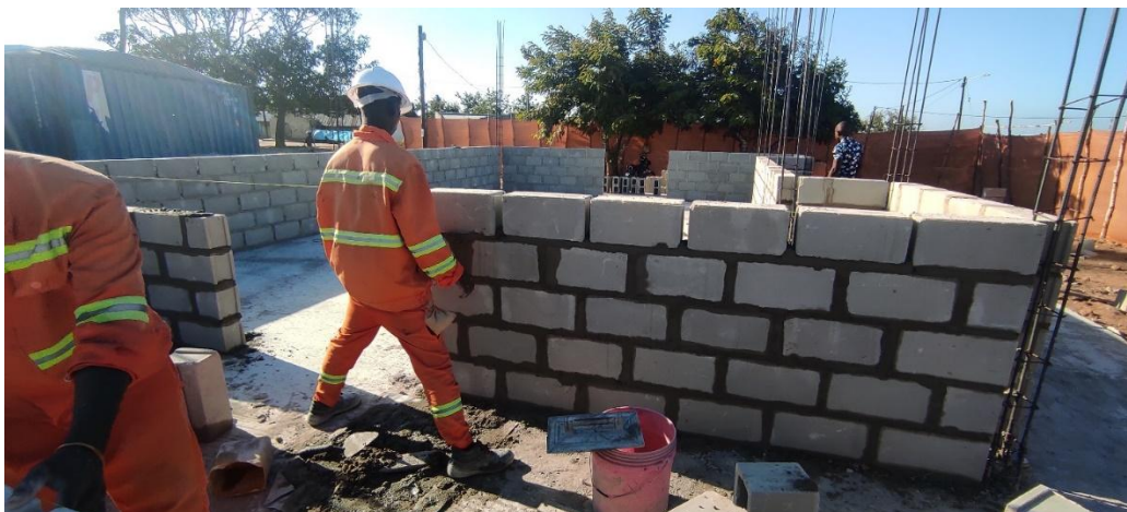
Alvenaria do mercado
