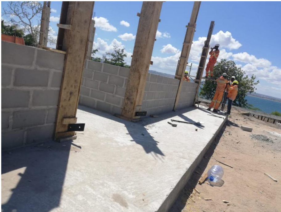
Execução de pilares no mercado
