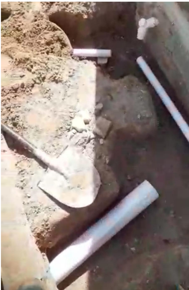
Tubos de esgotos e tubos de abastecimento
