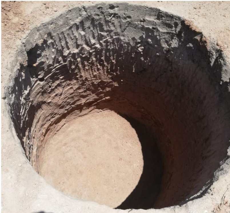
Escavação de dreno
