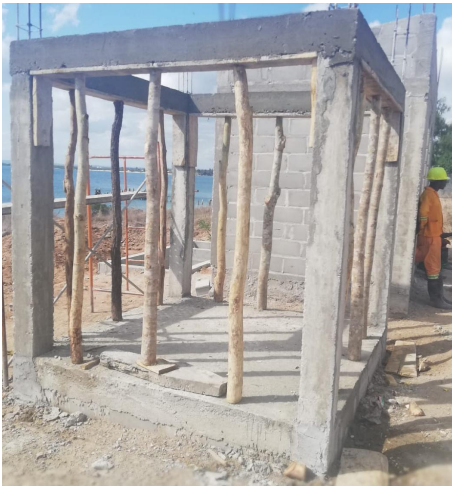
Estrutura de reservatorio superior
