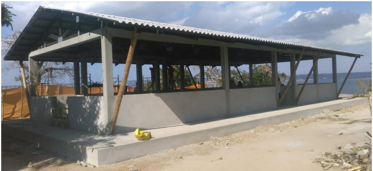
Acabamento das paredes do mercado
