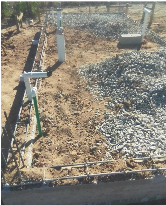
Tubos de esgotos e tubos de abastecimento
