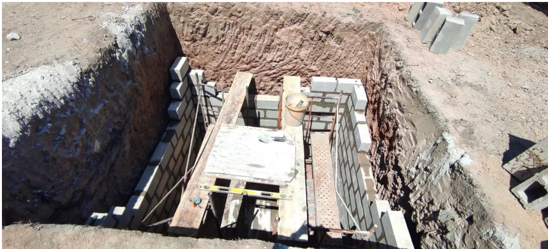
Alvenaria do mercado
