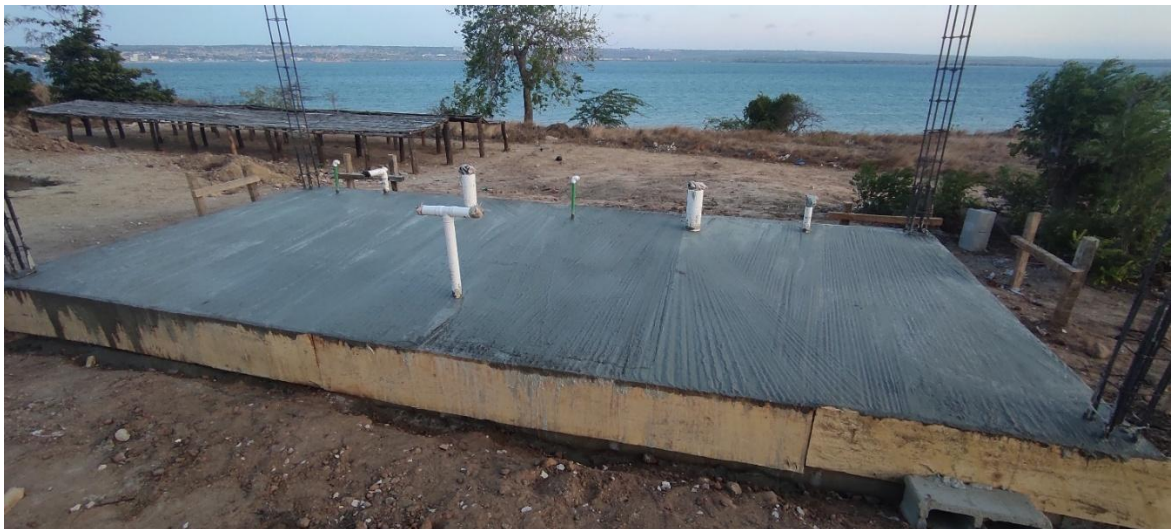
Betonagem da laje de pavimento
