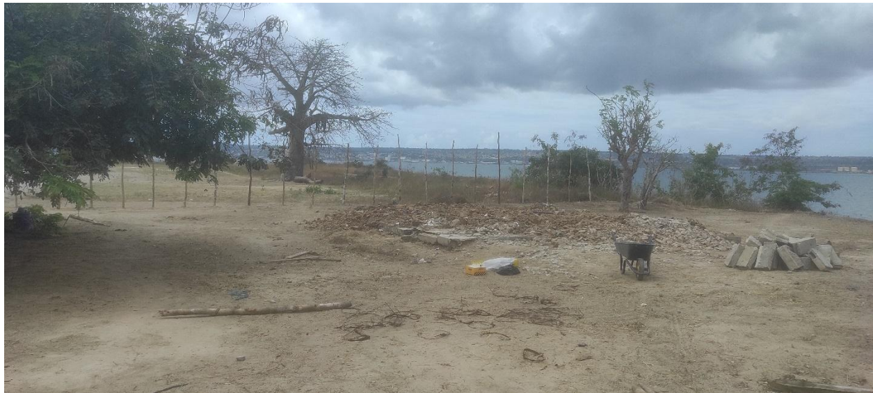
Figura 13: o terreno após limpeza (Foto tirada pelo autor)
