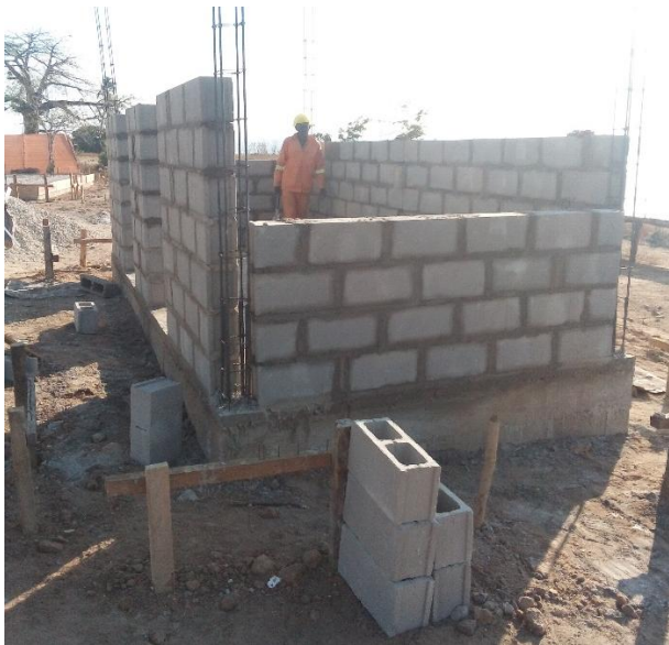
Alvenaria do sanitário
