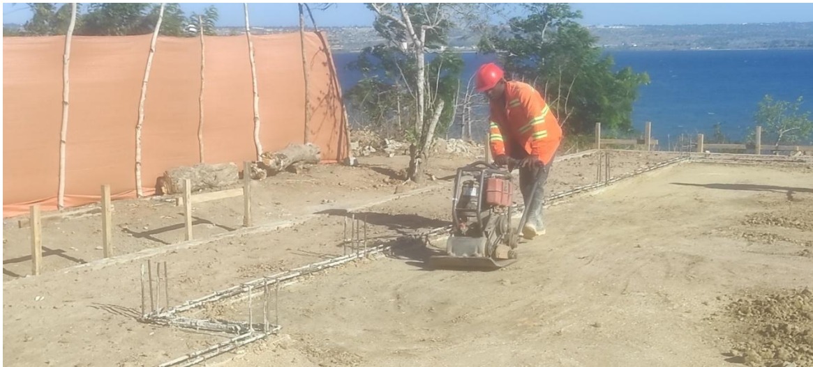
compactação do pavimento
