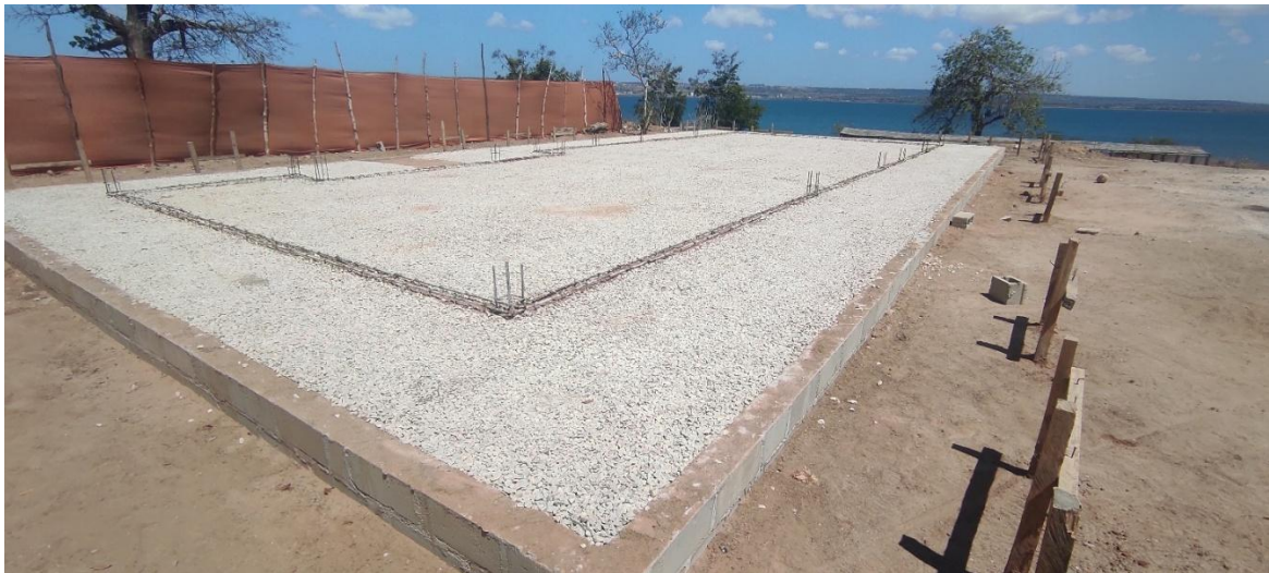
enrocamento de pedra no pavimento
