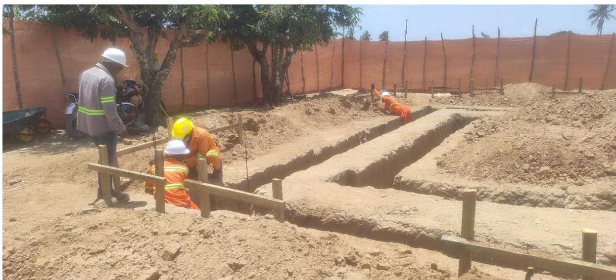
Abertura de caboucos da fundação do mercado de peixe.
