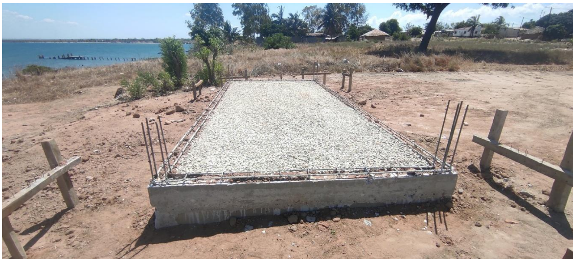
enrocamento de pedra no pavimento
