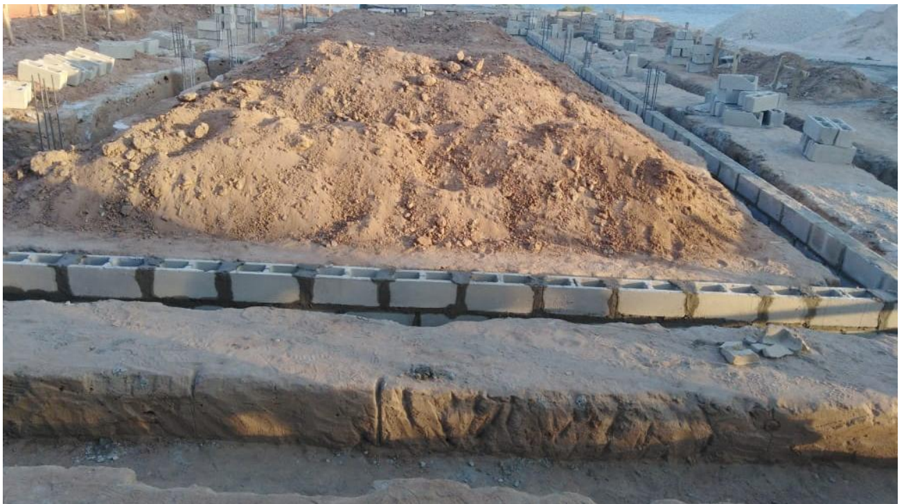
Alvenaria de fundação
