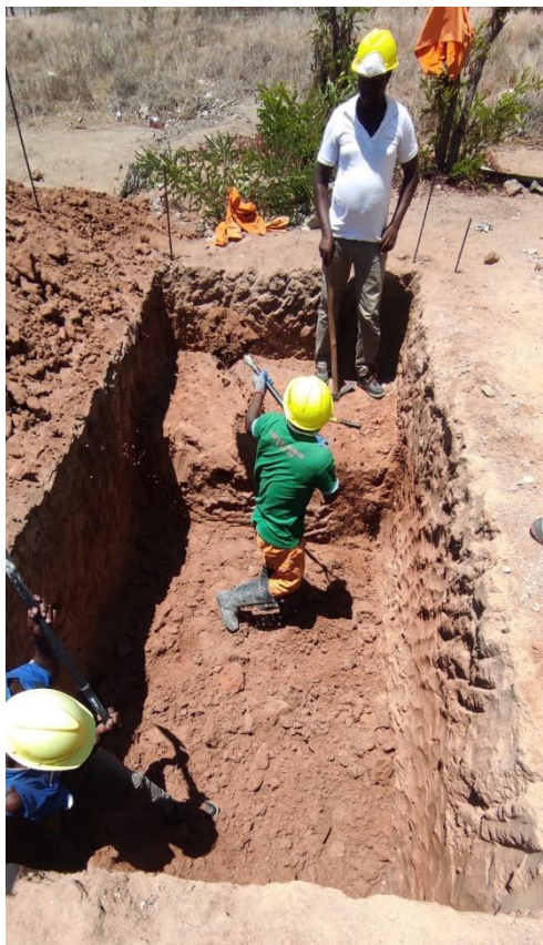
Escavação da fossa séptica
