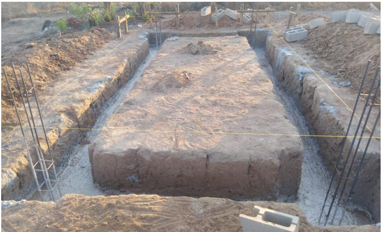
fundação do sanitário
