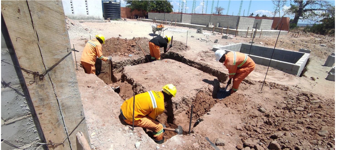
Escavação da fundação do tanque superior.
