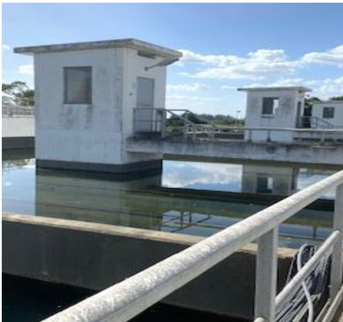
Figura 1. A Estação de Tratamento de Água (ETA) do Umbeluzi, província de Maputo (fonte: Autor).
