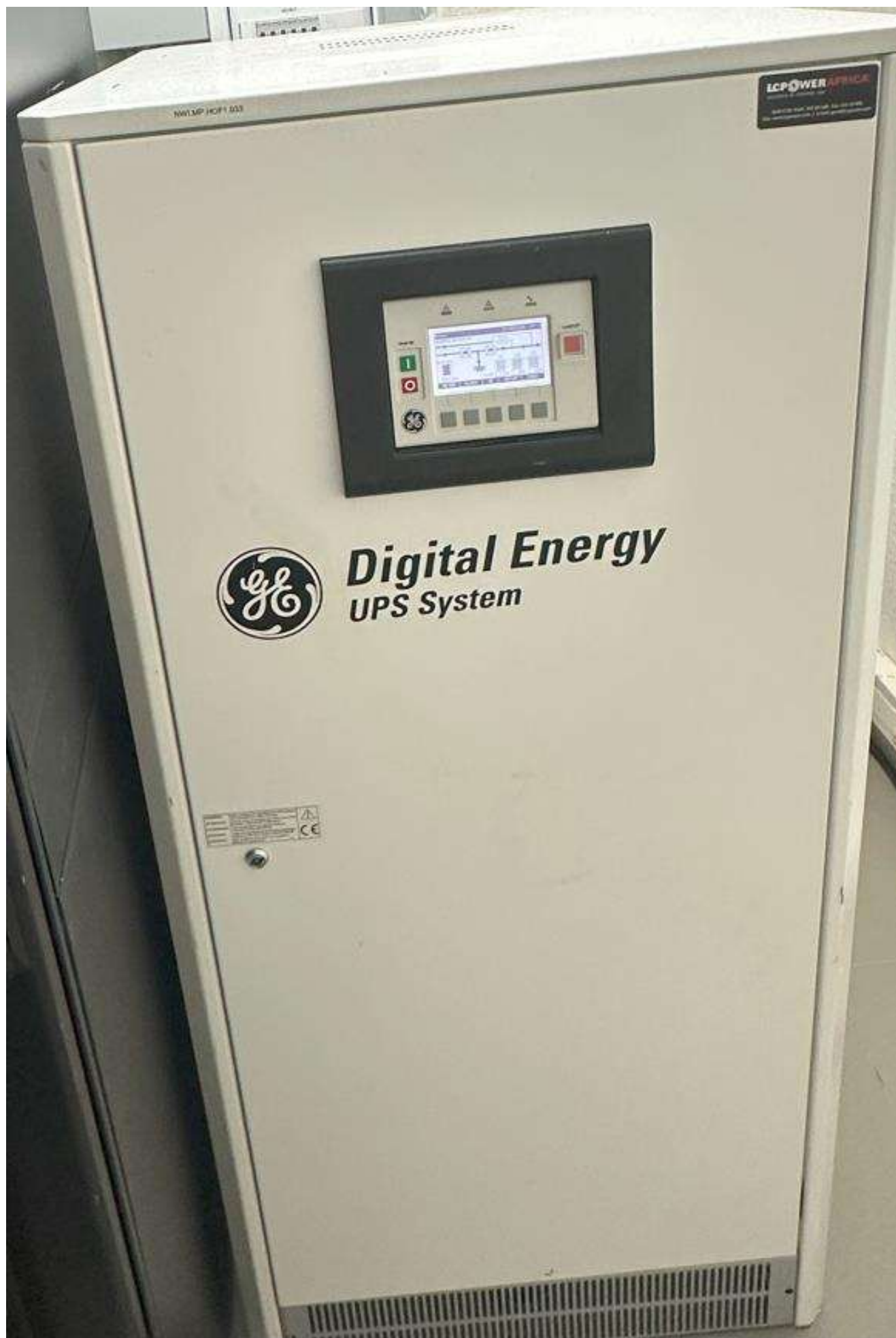
Figura A16-16: UPS de dupla conversão de 40 KVA. (Fonte: Autor)
