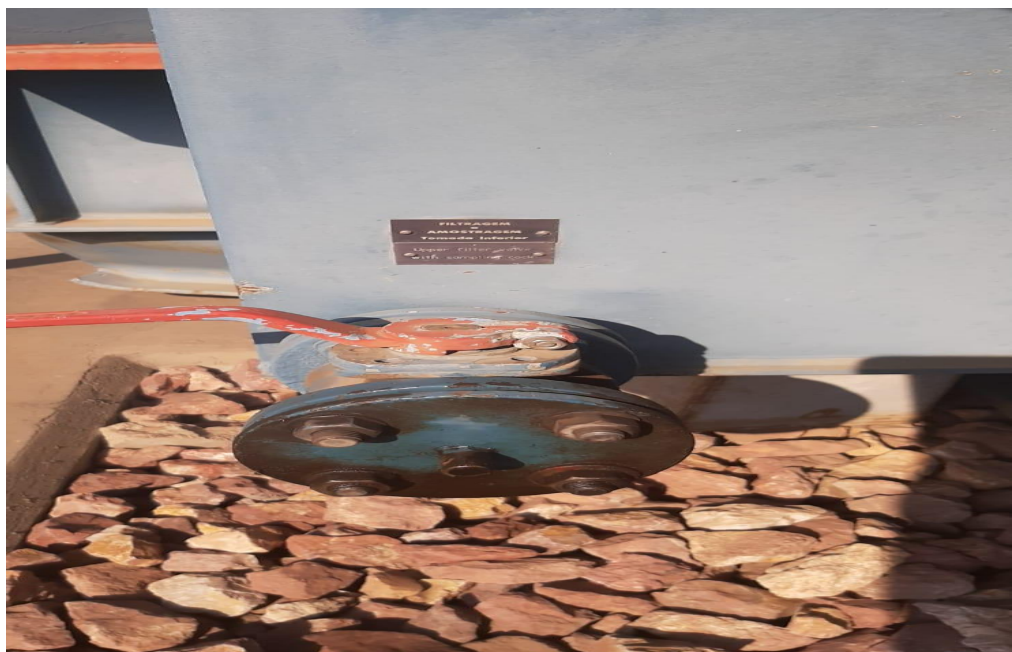
Figura A 3.3-6: Válvula para extração do óleo para análise.
