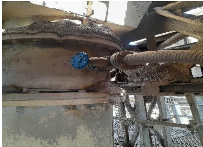
Figura 15: Válvula de amostragem da draga
