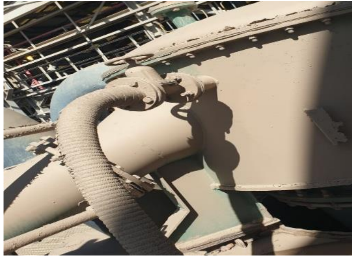
Figura 16: Válvula de amostragem da DCyF
