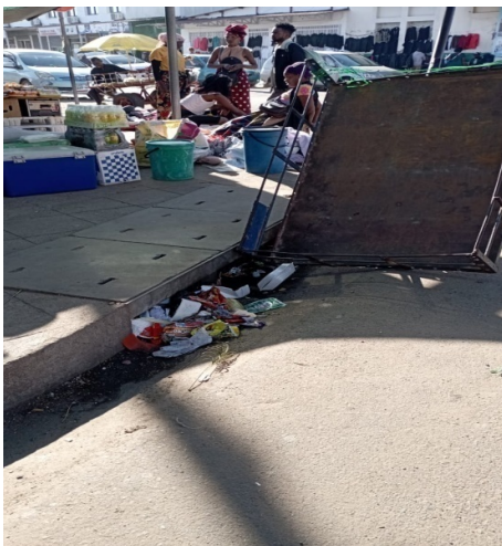
figura3: Boca de lobo coberto de resíduos sólidos Av. Guerra popular
