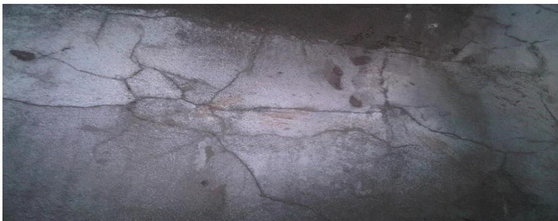
Figura 3 - Efeito da acção provocada pela reacção alcalina em agregados
