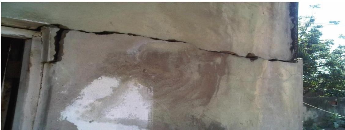
Figura 1 - Efeito da acção provocada por ataque pelos sulfatos
