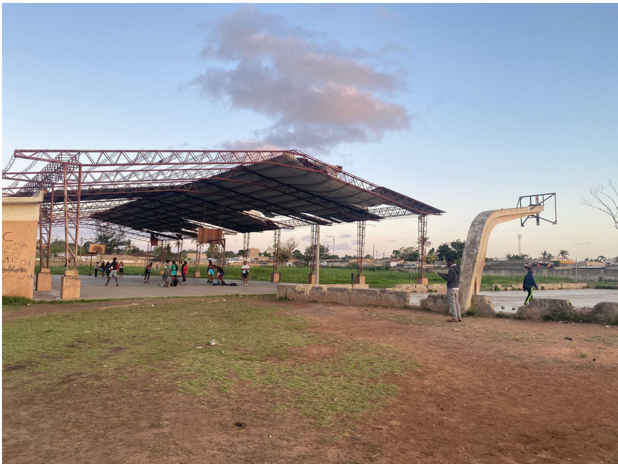
Anexo c: Ilustração do estado da infraestrutura desportiva
