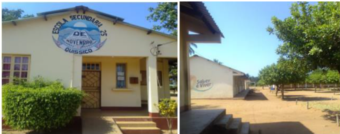
Figura 1.2: Escola Secundária 25 de Novembro de Quissico
