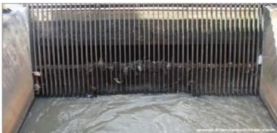
Figura 1: A imagem ‘A’ ilustra grade de contenção de uma estação de tratamento de esgoto (In: Franca noticias, 2012)
