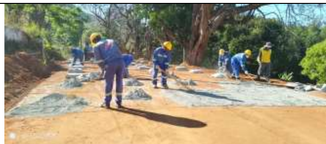
Foto 10 – Estabilização da Base
