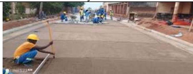
Foto 12 - Nivelamento da Almofada da Areia
