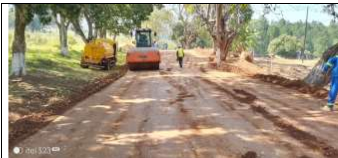
Foto 09 – Compactação da Base
