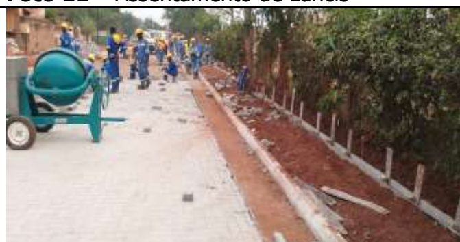
Foto 13 - Assentamento de Pave na Via e Passeio
