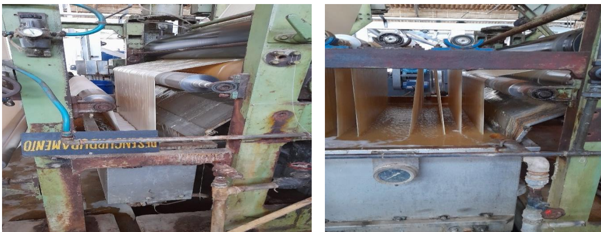
Imagem 3. 6: Desengorduradora. Fonte: Autor.
