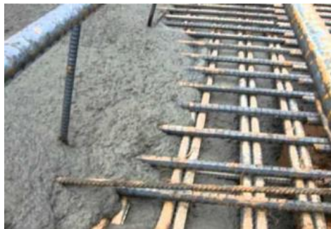
Figura 1. Betão Auto-Compactável passando por armaduras.
