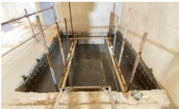
Figura 26. Armadura das vigas das escadas
