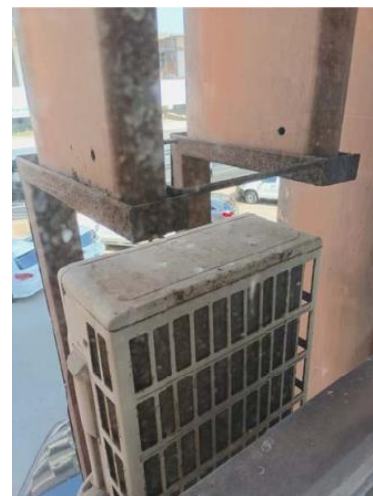
Figura 16. Levantamento no 1º andar para remoção dos Ar-condicionados e substituição dos Quebra-Sóis.
