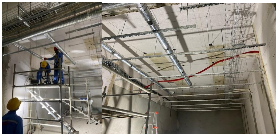
Figura 32. Instalação de Sistema de Climatização (AVAC)
