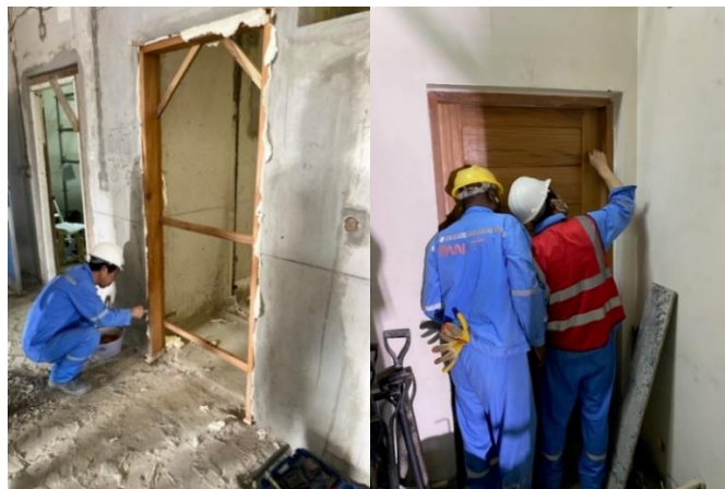
Figura 38. Instalação de portas de madeira
