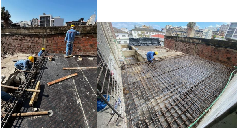
Figura 29. Armadura das vigas e da laje.
