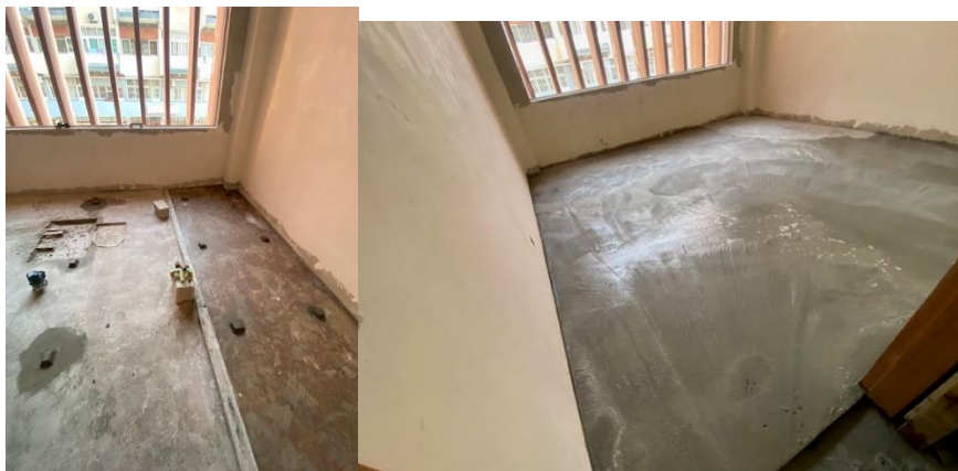
Figura 35. Aplicação de Betonilha
