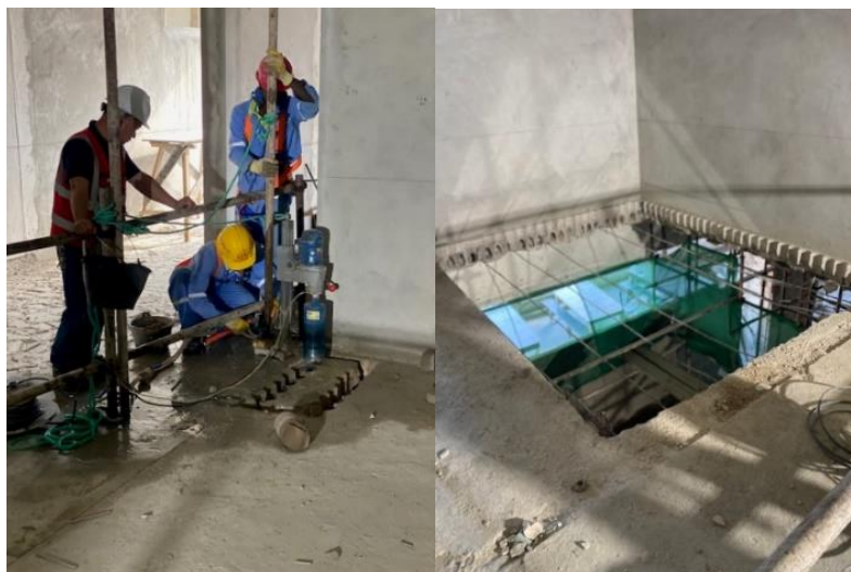
Figura 20. Abertura da laje para instalação de escadas metálicas.
