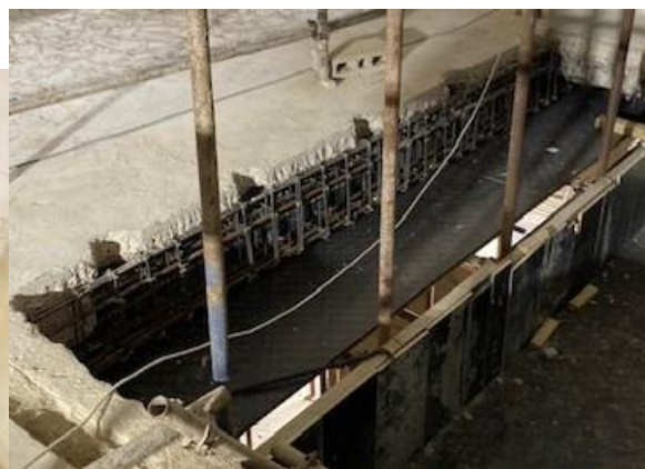
Figura 26. Armadura das vigas das escadas
