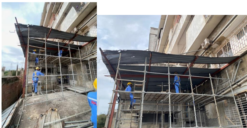
Figura 17. Remoção da cobertura com chapas de zinco.
