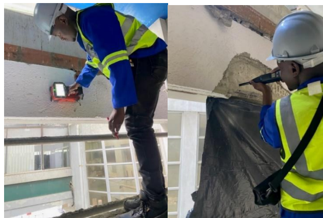
Figura 43. Realização dos ensaios das vigas
