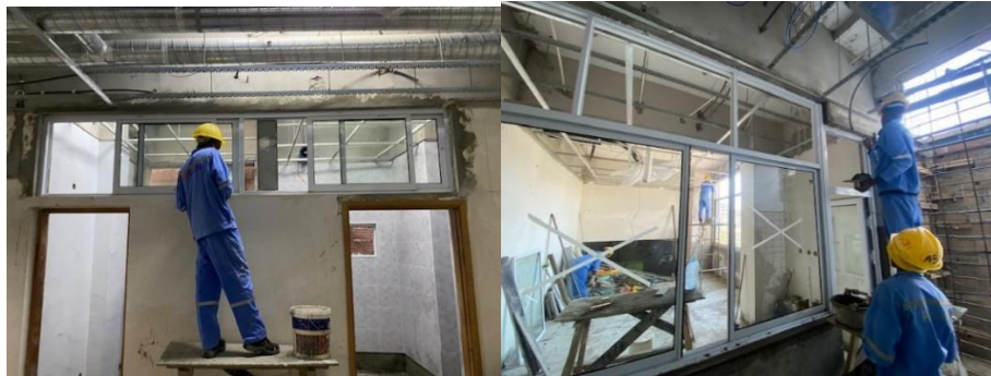
Figura 39. Instalação de janelas
