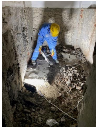
Figura 18. Demolição da parede
