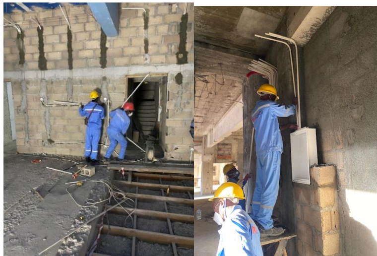
Figura 30. Instalação de nova Rede Eléctrica
