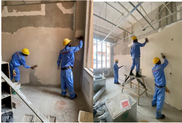
Figura 37. Aplicação da massa de Barramento nas paredes
