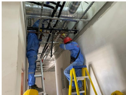
Figura 34. Instalação de Sistema de Segurança contra Incêndio
