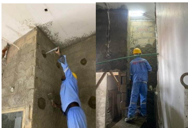
Figura 28. Instalação de geogrelha e reboco das paredes
