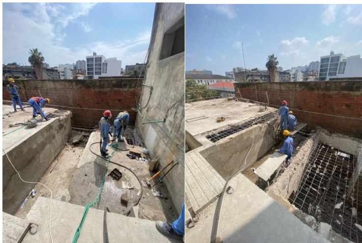
Figura 21. Demolição das lajes
