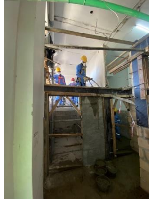
Figura 24. Betonagem de lintéis
