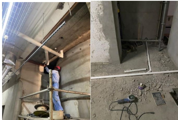
Figura 33. Instalação de Redes de Águas e Esgotos
