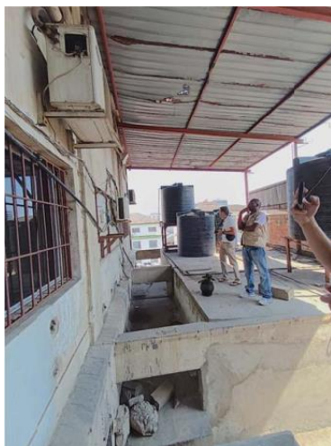
Figura 15. Levantamento no 2º andar para remoção de tanques e da cobertura e, demolição da laje.
