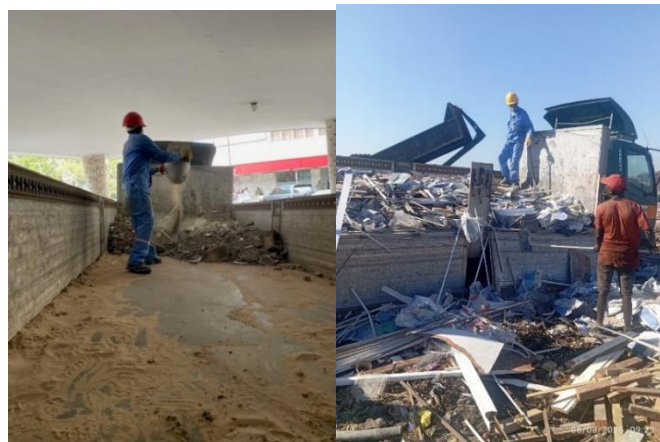
Figura 22. Remoção de resíduos sólidos
