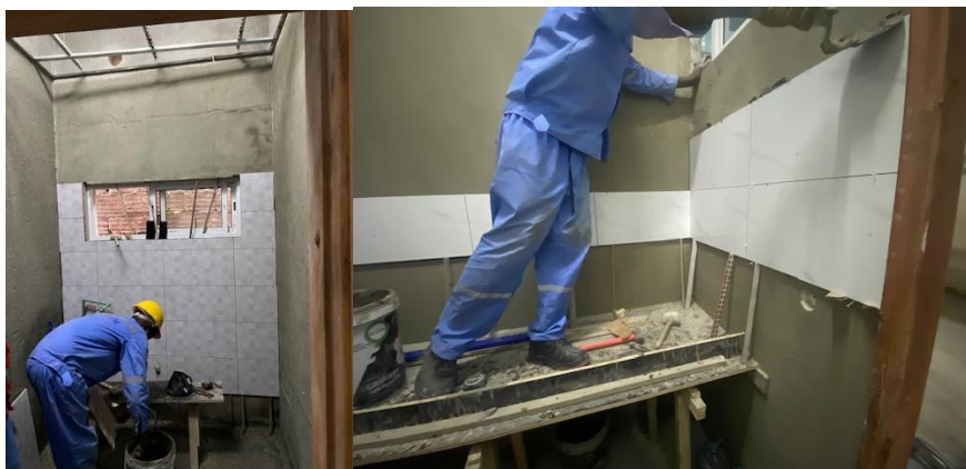
Figura 40. Instalação de tijoleiras
