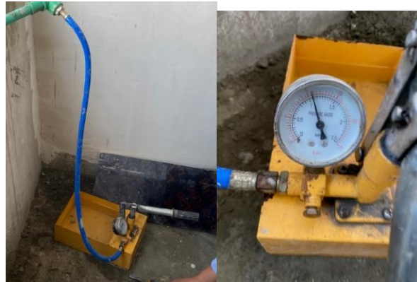
Figura 41. Ensaio de cargas em Tubagens
