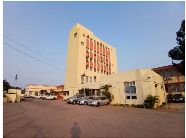
b) Vista frontal do DMC, evidenciando a torre e o seu corpo principal em altura
