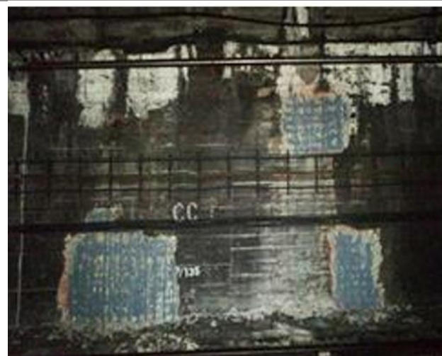
b) Armaduras protegidas com inibidores de corrosão
