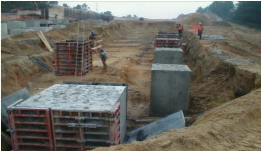
Figura 11 Fundações por poços
