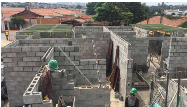
Figura 2-4: Estrutura em alvenaria estrutural, ( https://www.rb2eng.com.br/wp-content/uploads/2020/11/0327.jpg ).
