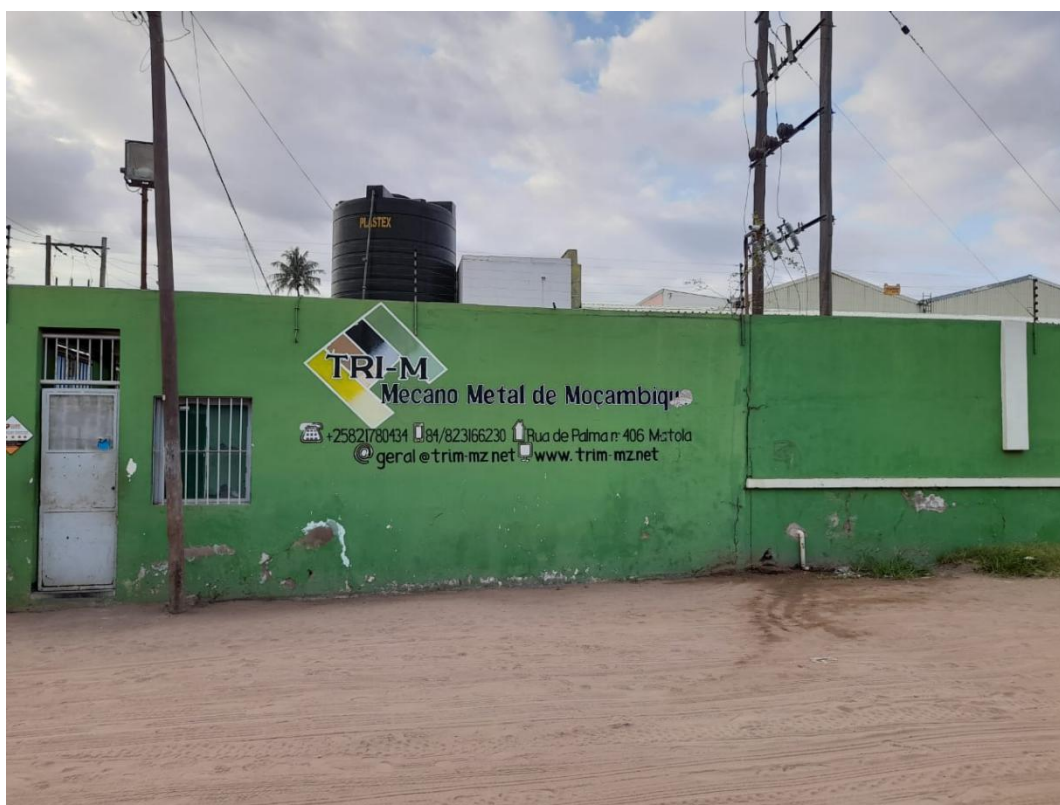
Figura 13 - Actuais instalações da empresa TRI-M Mecano Metal de Moçambique (Fonte: TRI-M)
