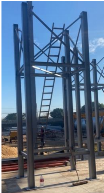
Figura 17 - Pre-montagem da torre de suporte da tubagem (fonte: TRI-M)
