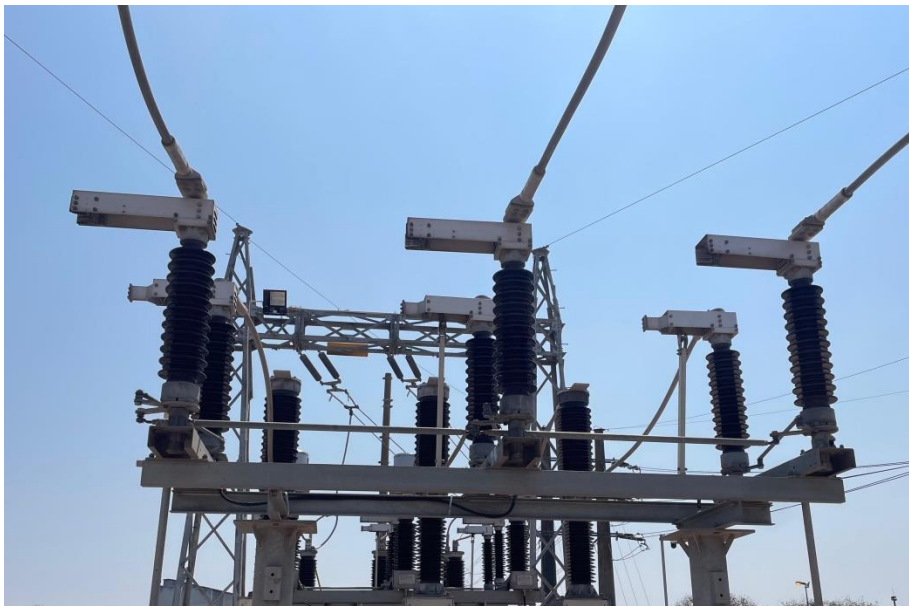
Figura 5: Seccionador e respectivo símbolo
