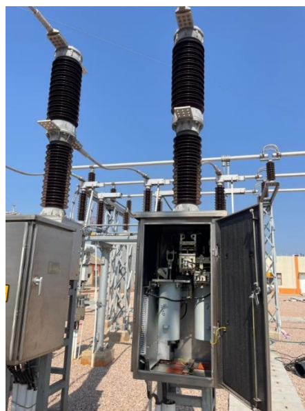
Figura 7: Disjuntor a SF6 e respectivo símbolo
