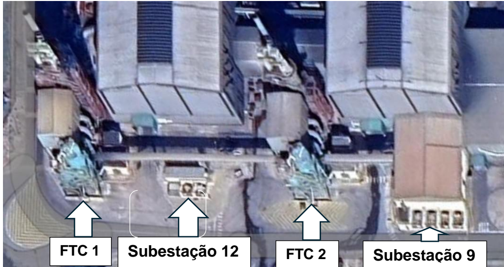
Figura 27 – Localização da subestação 12 na área do Carbono da Mozal (Fonte: Google Maps, 2025)
