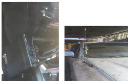
Figura 7: Instalação do Transreceptor Motorola XPR 535506-VHF (Fonte: Autor)
