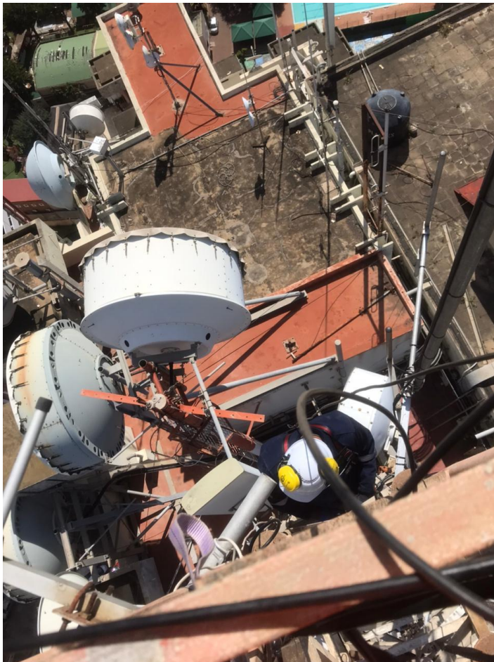
Figura 8: mudança do cabo coaxial que conecta a antena ao transmissor (Fonte: Autor)
