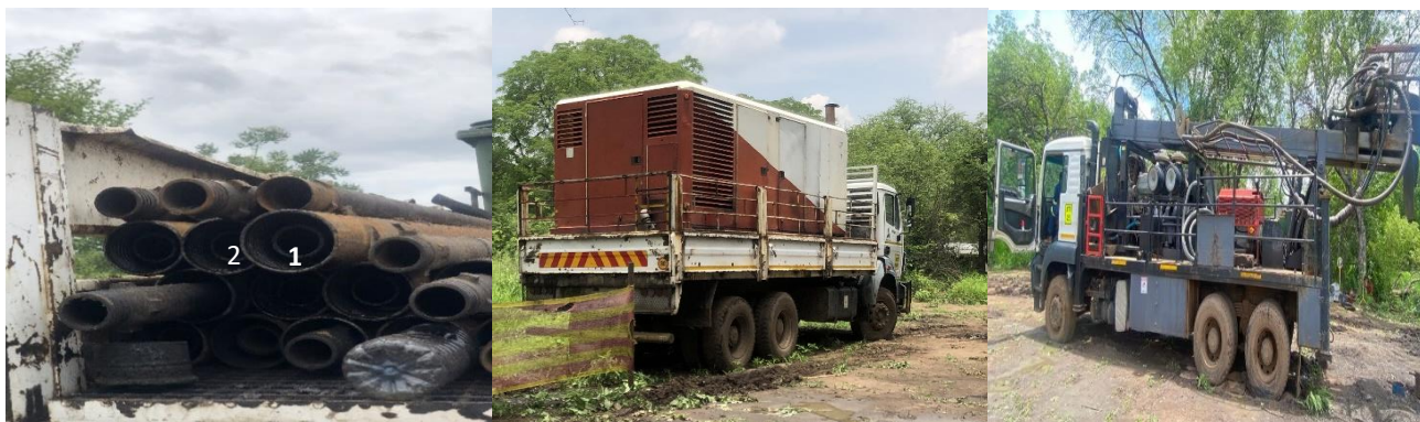
Figura 1: Materiais usados durante da abertura dos furos de Sondagem (LD): A-1.Haste de diâmetro menor e 2.haste de diâmetro maior; B- Compressor de ar; C- Perfuratriz da Thompson Drilling. Fonte:Autora
