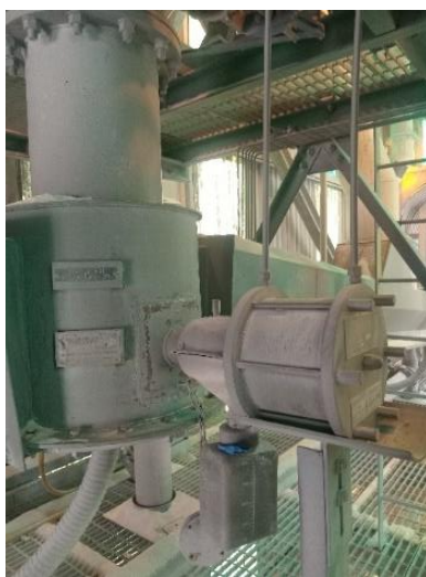
Figura 20: Amostrador automático de alumina secundária.
