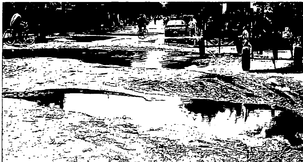
Figura 7. Exemplo de estrada esburacada e sem infra-estrutura de drenagem tornando-a intransitável na época chuvosa.
