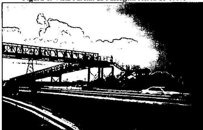
Figura 1. Vista Parcial da Passagem Aérea do Trevo
