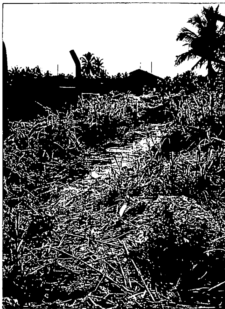
Uma das valas de drenagem na unidade de Kansa, 1997.
