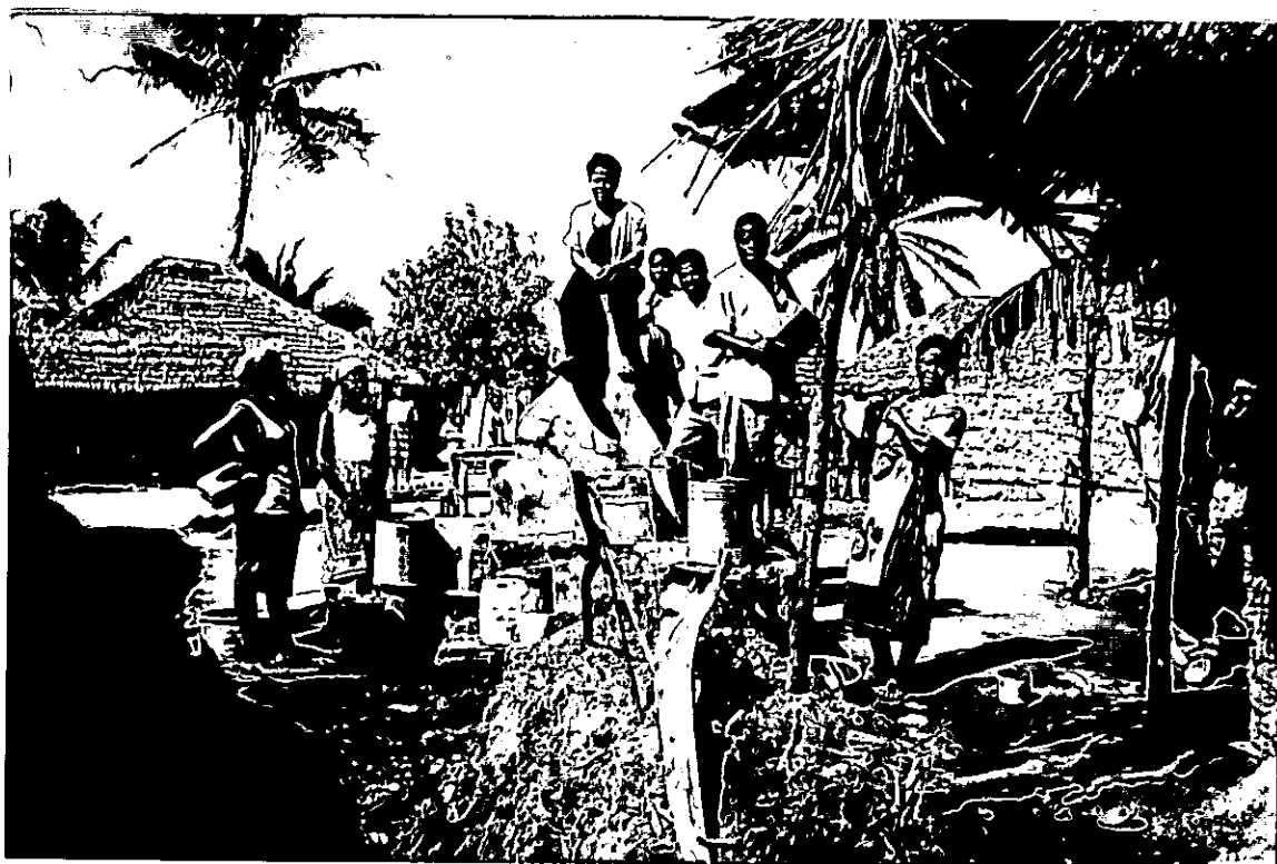
Unico fontenário em funcionamento na unidade de Kansa, 1997.
