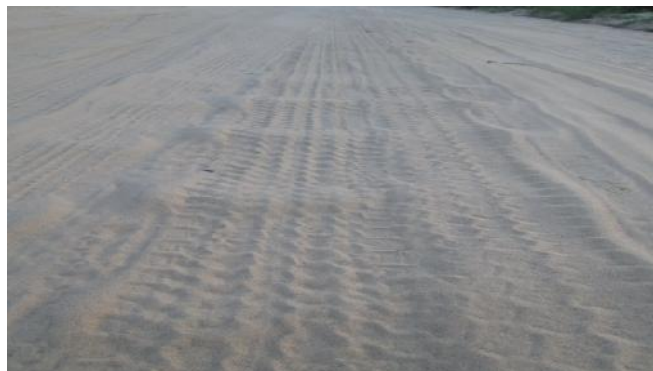
Figura nº 11 ondulações na estrada Vilankulo Madeira – Chibuene
