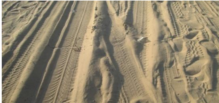
Figura nº14 agregados soltos na estrada Vilankulo Madeira – Chibuene
