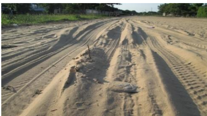
Figura nº 13 afundamento das trilhas de rodas na Vilankulo Madeira – Chibuene
