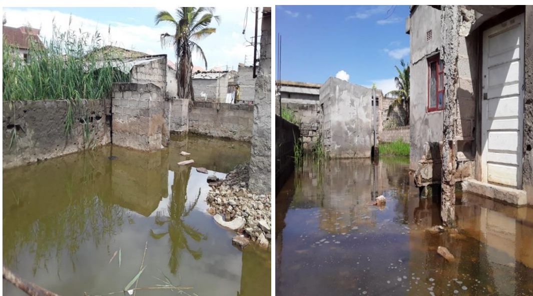
Figura 4.1. Invasão das águas contaminadas (de latrinas) nas casas.
