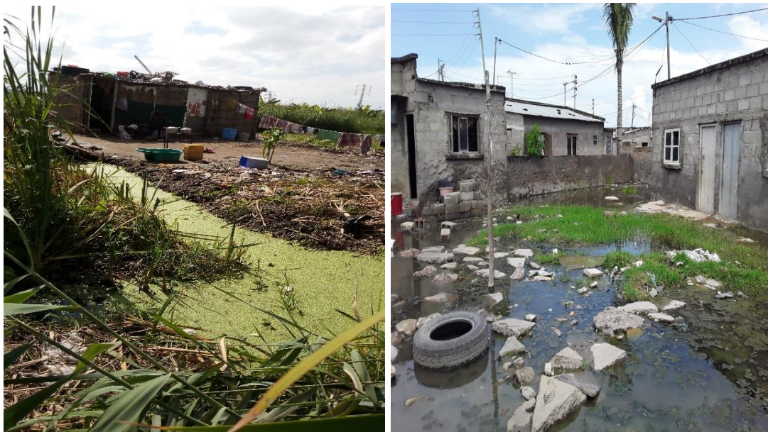
Figura 4.4. Pequena vala aberta e talhão entulhado com pedras.
