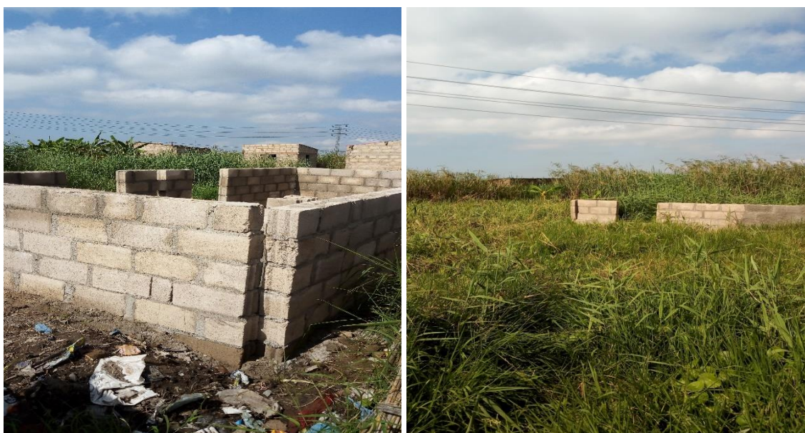
Figura 4.3. Obras de erguer casas num solo inundado.
