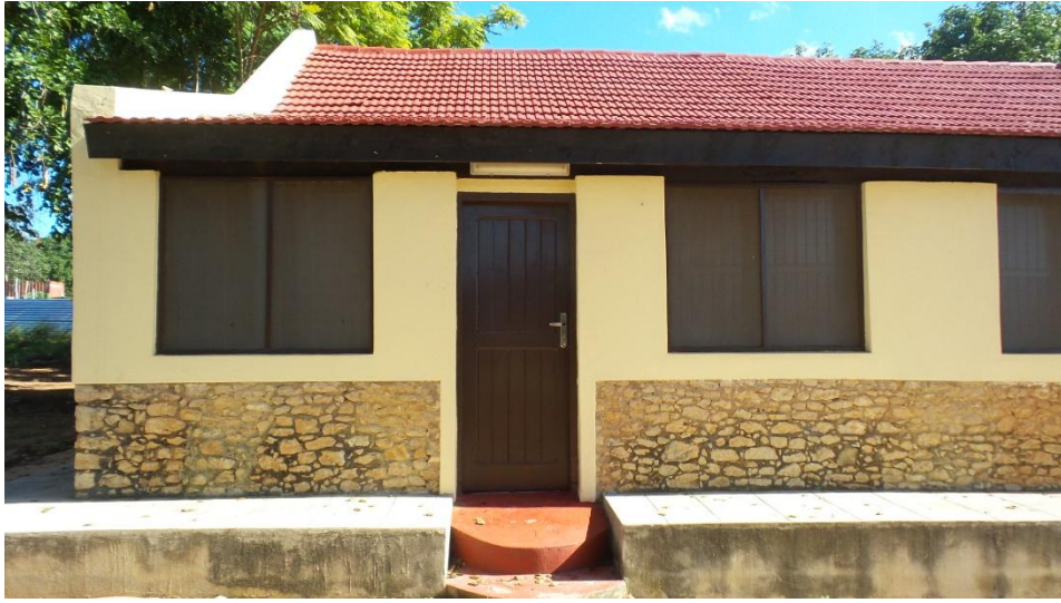
Figura 12 – Dormitório do Eduardo Mondlane depois da reabilitação
