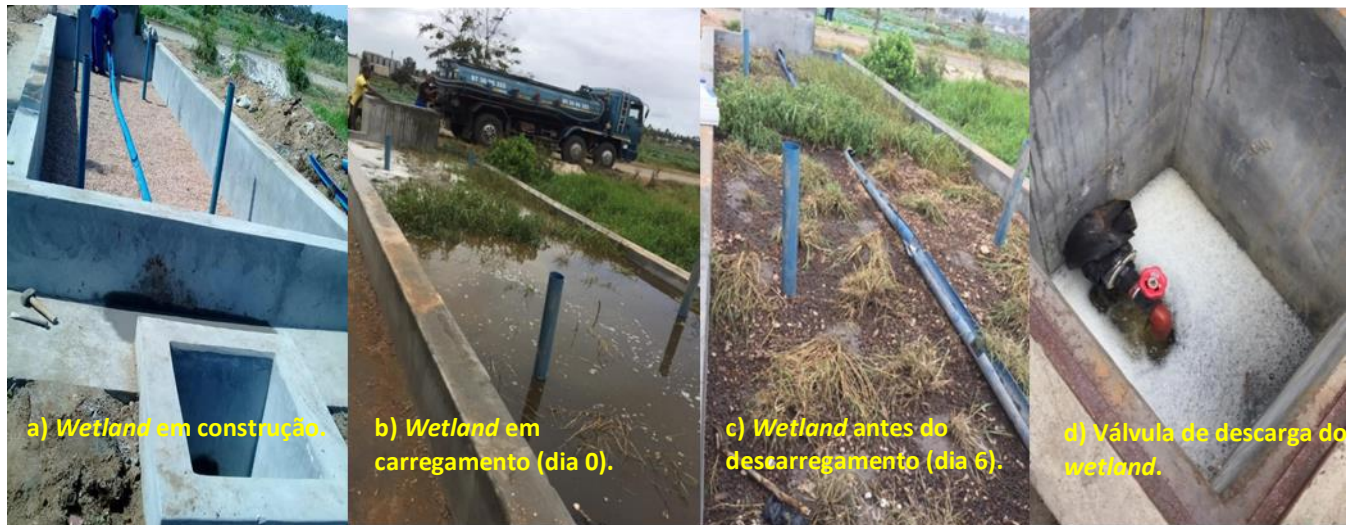
Figura 5: Ilustração do wetland construído de fluxo vertical.
