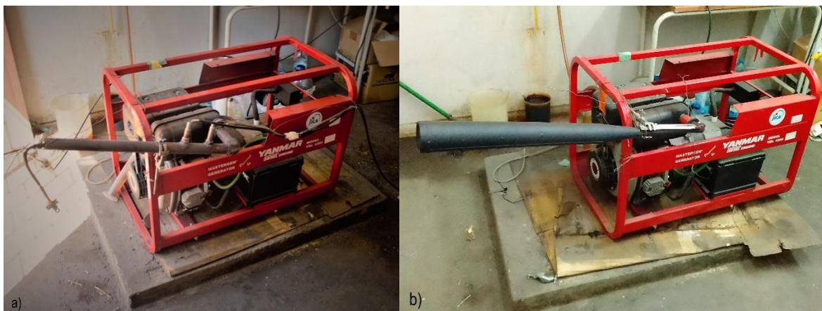
**Figura 10:** Motor Gerador: a) Sem Abafador; b) Com Abafador.
