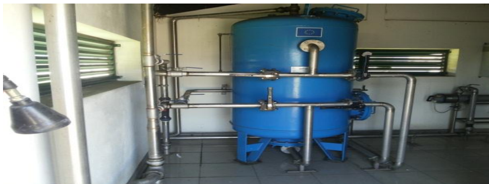
Figura nº22: Filtro de Areia e Sistema Ultra Violeta
