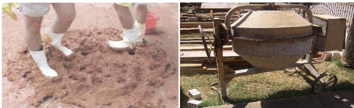
Figura 6: a) Amassamento feito artesanalmente
