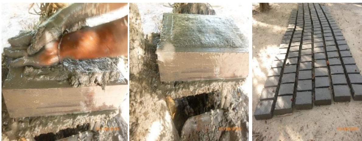
Figura 12: Conformação das peças
