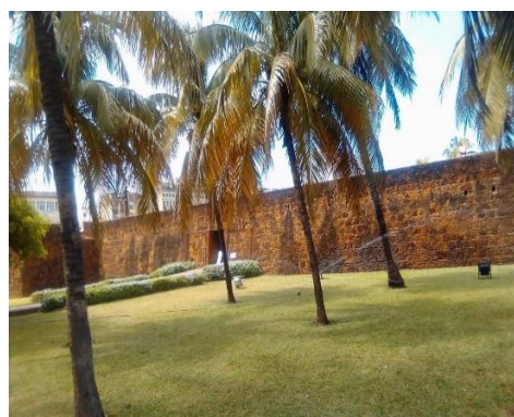
Figura 2. Vista exterior da fortaleza
