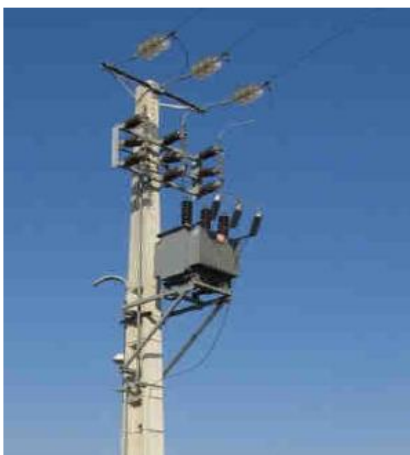
Figura 4: Vista geral de um PT do tipo AI.
